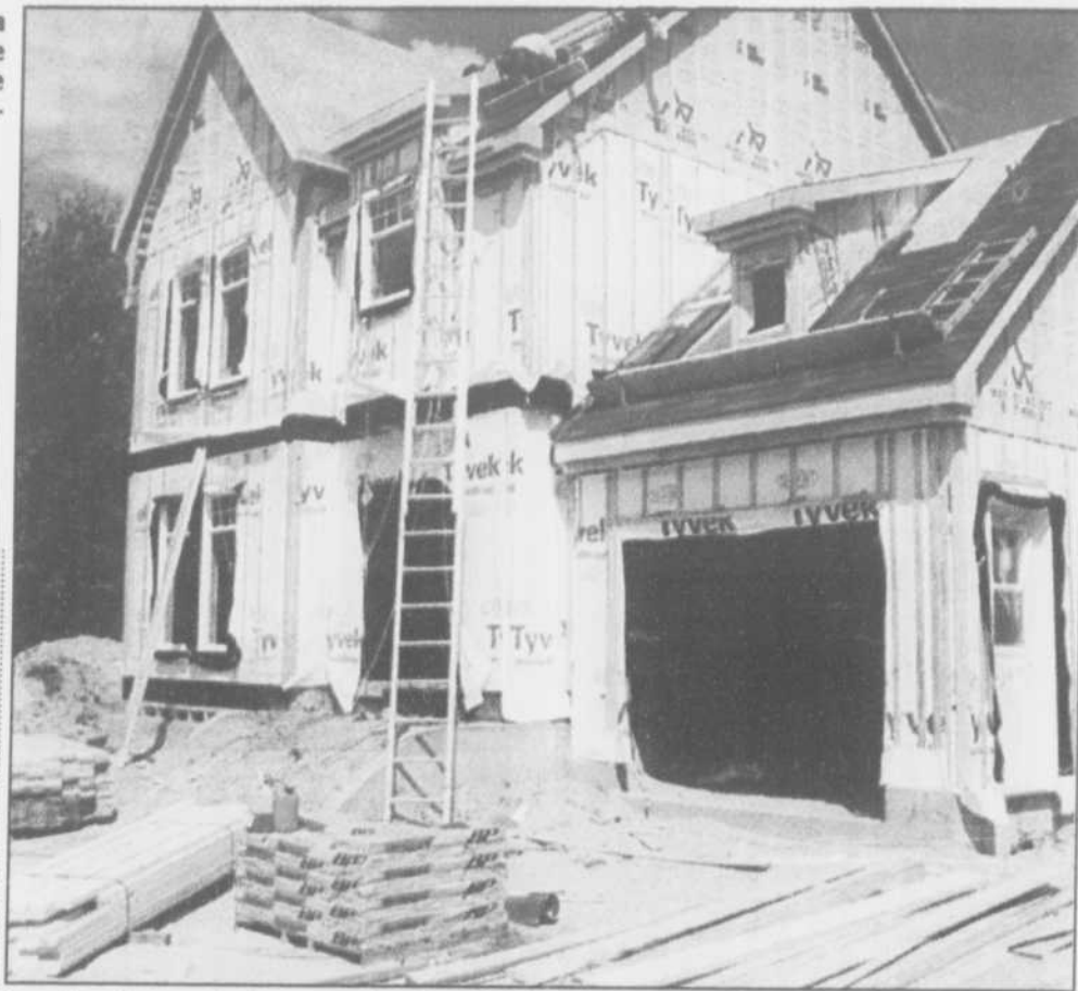
La valeur des permis de construction dans les villes de la MRC des Moulins a atteint 102 758 235$ pour les six premiers mois de 2002, un record si l'on se fie aux chiffres enregistrés au cours des cinq dernières années. (photo : Gilles Bordonado)
