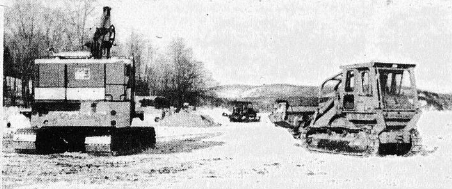
Les rives du lac Maskinongé ont été transformées en chantier de construction, cette semaine, à Saint-Gabriel, alors qu'on a procédé aux travaux d'installation de l'intercepteur.
