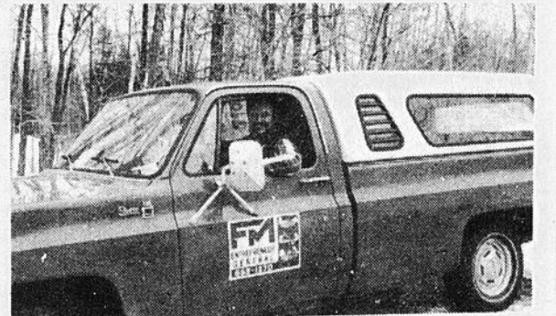
M. Normand Poulin agit comme surintendant des travaux sur le chantier du lac Maskinongé, où on est à poser un intercepteur.
