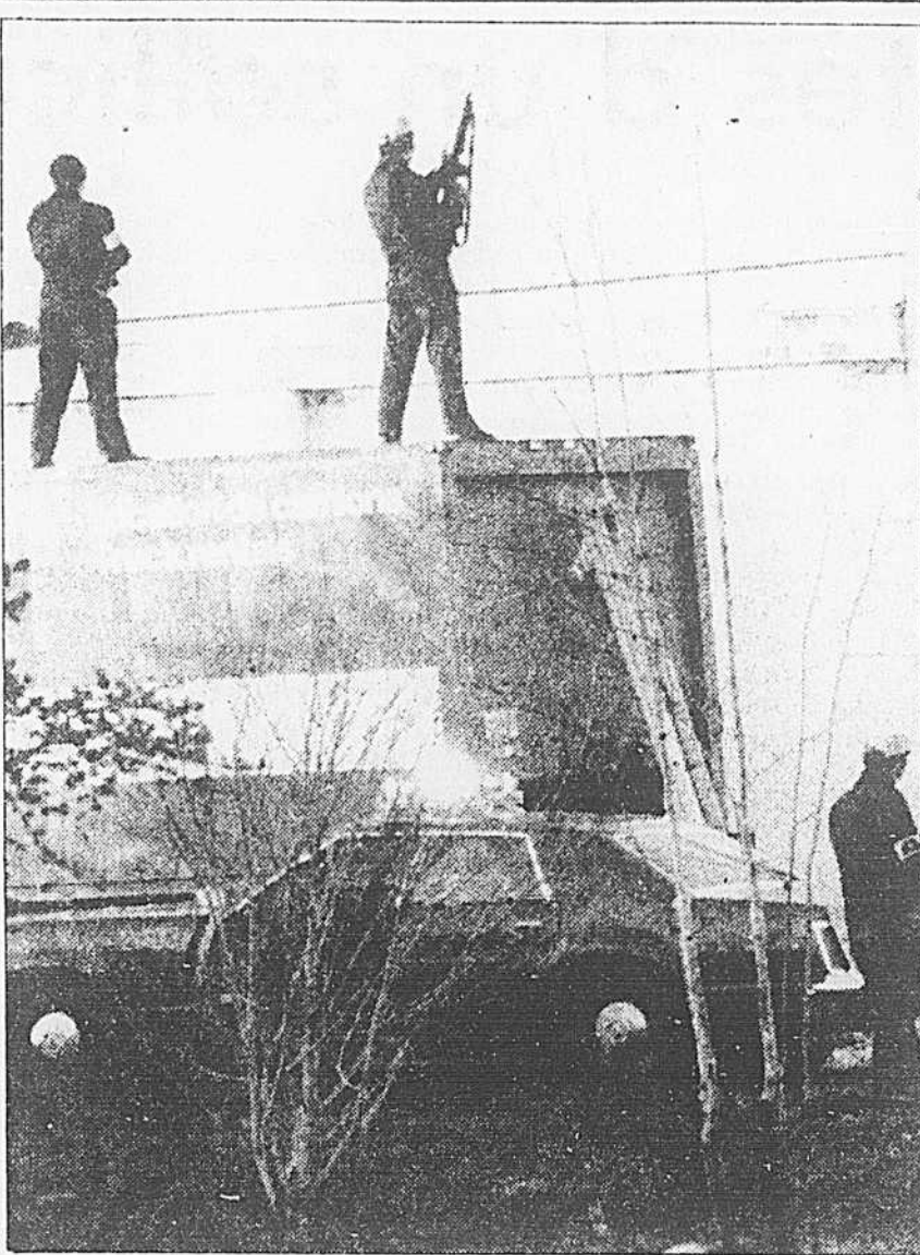
Des policiers surveillent la sortie de secours aménagée sur le toit du local des Missiles.
