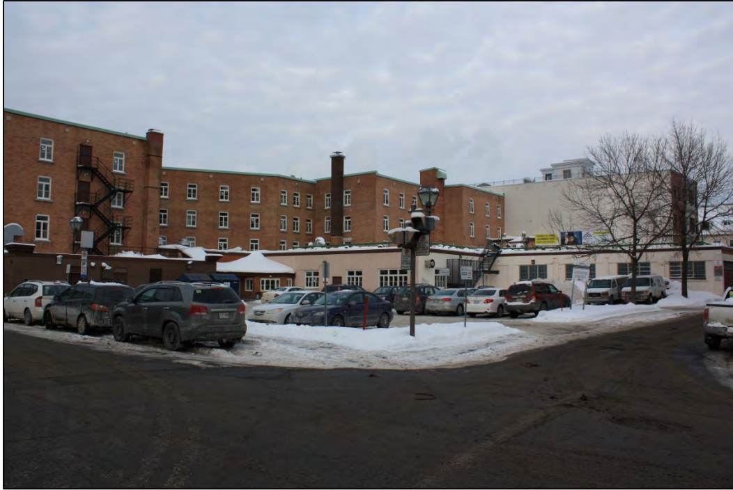
Photo 2. Vue des bâtiments de la Maison de Lauberivière qui seront démolis, vers le nord (RUR-POT-LAUBERIVIERE-2015-010)
