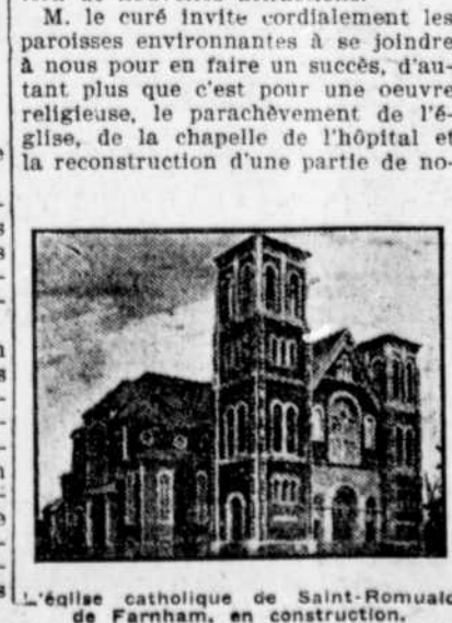
L'église catholique de Saint-Romuald de Farnham, en construction.
