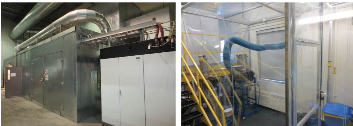
Figure A4. Confinement des zones de travail.
