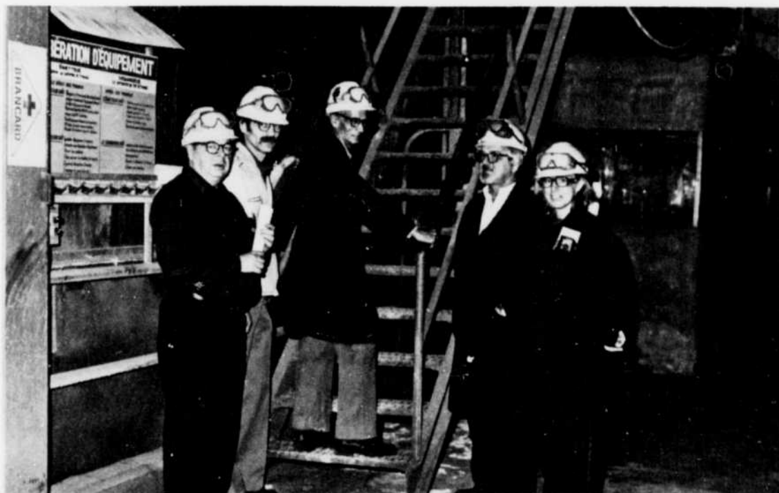
Ce nouvel escalier donne maintenant accès aux nouvelles passerelles des filtres-presses Kelly. On reconnaît le contremaître général, Gaëtan Moore, le surintendant adjoint de l'usine d'hydrate 1, Jean-Claude Ferlatte, le consultant technique, Philippe Boudreault, le technicien de projet, Thomas Émond, l'ingénieur de projet, Barbara Olejnik. (Photo: Wilfrid Lafrance)
