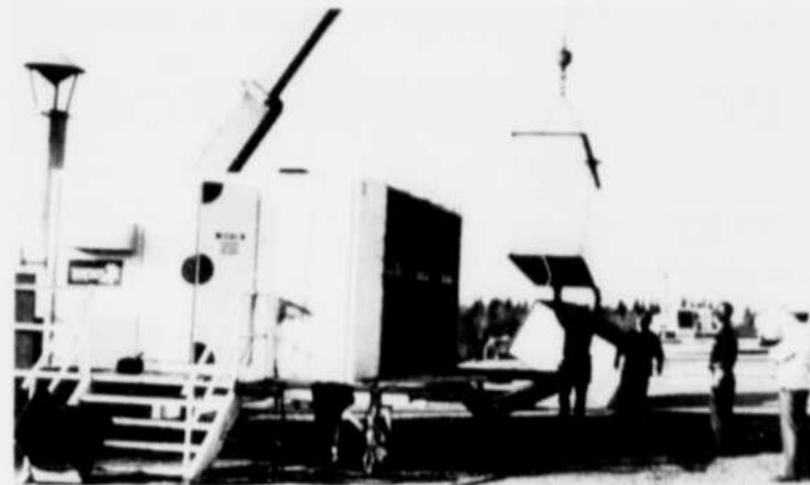
Le 28 octobre dernier, une équipe d'employés installait sur le toit de la bâtisse 420, le système qui permettra de réchauffer le bâtiment tout en économisant l'énergie.
