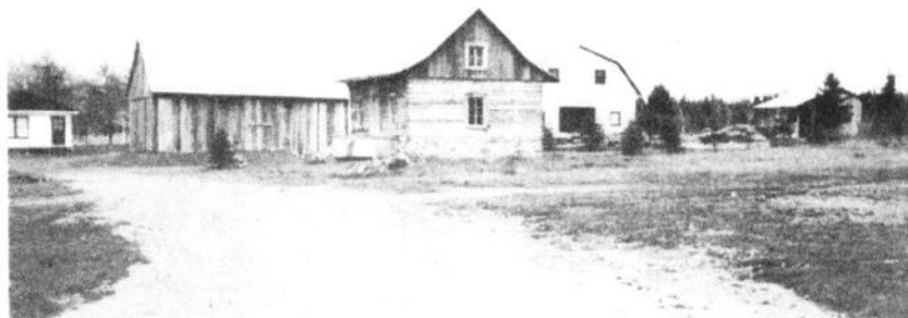
Les travaux vont bon train du Musée des Défricheurs.
