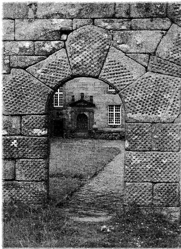
Lannilis, vue de la porte d'entrée piétonnière donnant accès à la cour du château.
