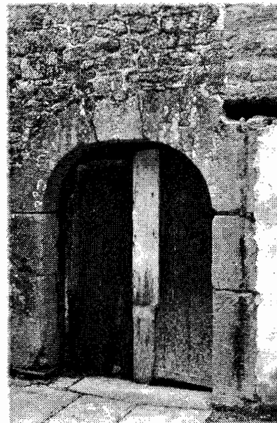
Porche utilisé par l'ancêtre, pour accéder au rez-de-chaussée de la dépendance. On peut voir, gravé dans la pierre, la date de construction de ce porche, soit 1668.
