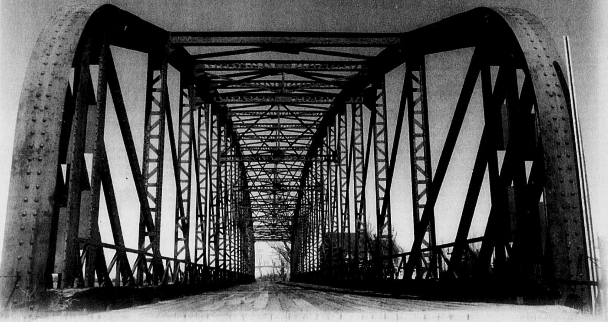
Le pont Turcot construit en 1889
