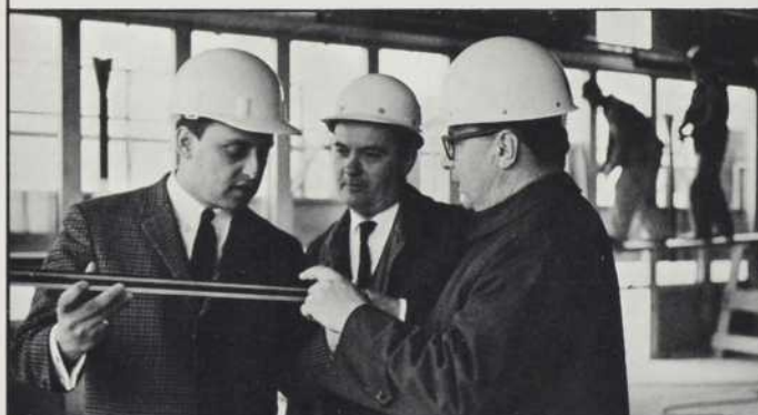
Sur le chantier. De g. à d.: B. Himel—Webb, Zerafa & Menkes. W. Evans—Yolles & Rotenberg. R. Lesick—Pilkington.
