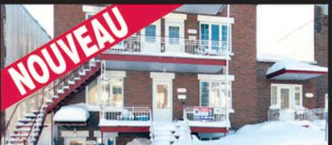
LIMOILLOU, 344-352, 16 e RUE , super immeuble, 5 logis : 3 1/2 sur 2 niv., 2 x 4 1/2, 5 1/2 et 7 1/2 pour proprio-occupant. 435 000$
