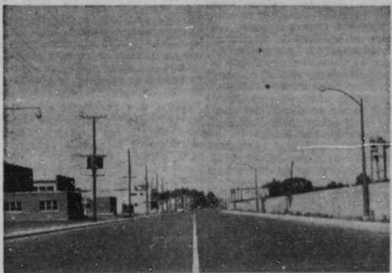
REFECTION DE LA RUE HOCHELAGA. — La rue Hochelaga a été repavée depuis le boulevard Pie IX jusqu'aux limites de la cité à la rue Georges V. L'éclairage et les trottoirs ont également été refaits. Au delà du tunnel du CNR, où il existe peu de rues transversales, l'on n'a pas érigé de terre-plein pour ne pas gêner inutilement l'accès des riverains à la rue.
