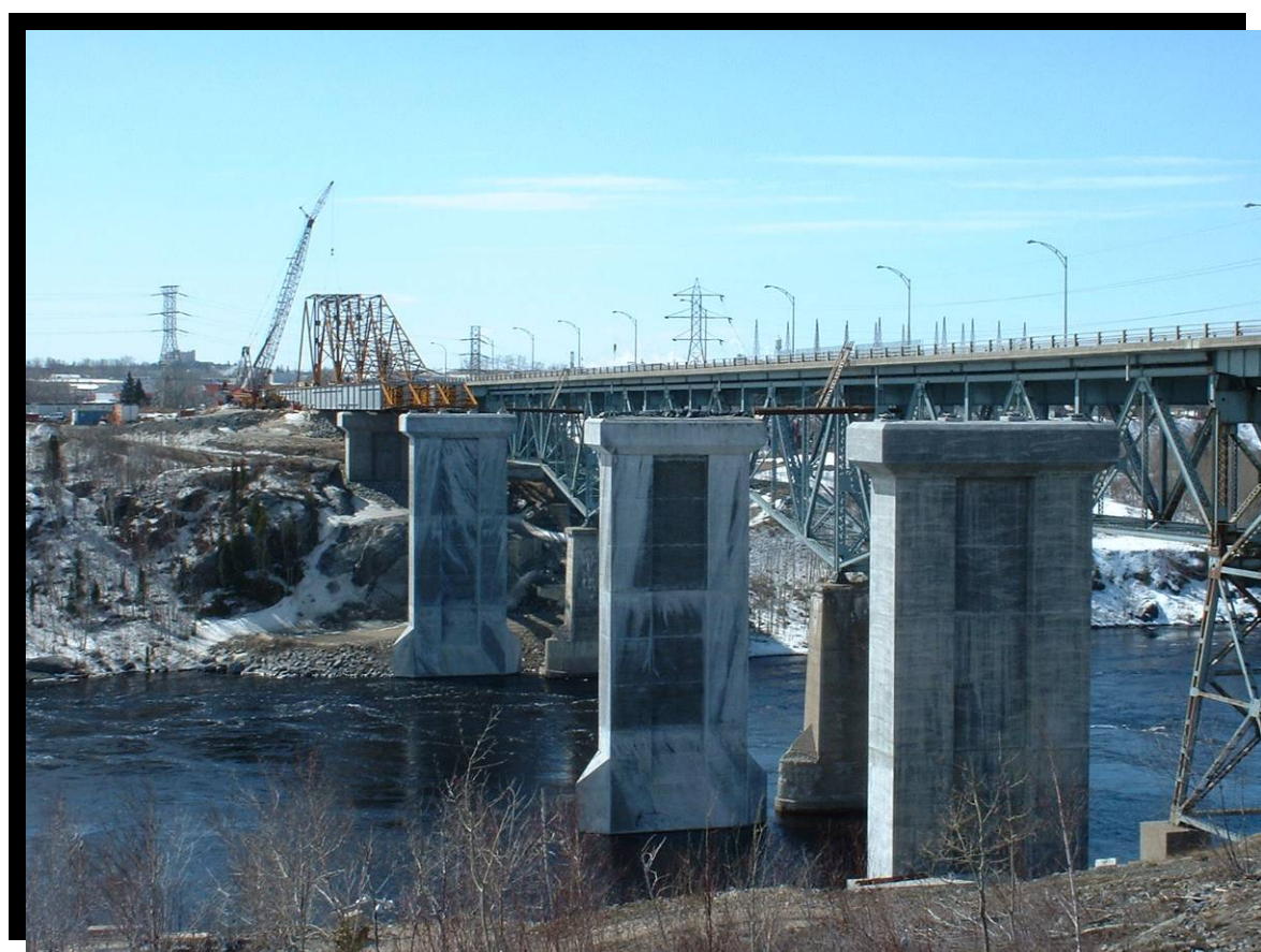
FIGURE 88 Photo prise lors de l'opération de lancement des poutres. Pont à poutres d'acier avec 5 piliers dont 2 dans la rivière La Grande Décharge. Aucune intervention dans la rivière entre les piles. Reconstitution du lit de la rivière entre les piles et les rives. Engazonnement et plantation sur les bandes riveraines. Route 169 à Alma. (2003.1101)
