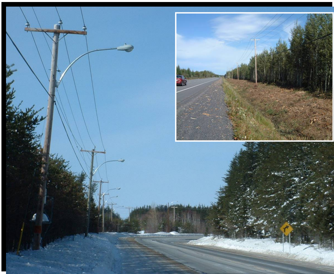
FIGURE 161 Éclairage d'un tronçon de route où plusieurs collisions se sont produites avec les orignaux en raison de la proximité du parc national de la Pointe-Taillon. Au coin droit, déboisement de l'emprise pour améliorer la visibilité du conducteur et éliminer les aires d'abri pour l'orignal dans le corridor routier. Route 169 à Saint-Henri-de-Taillon et à Sainte-Monique. (2003.1172)
