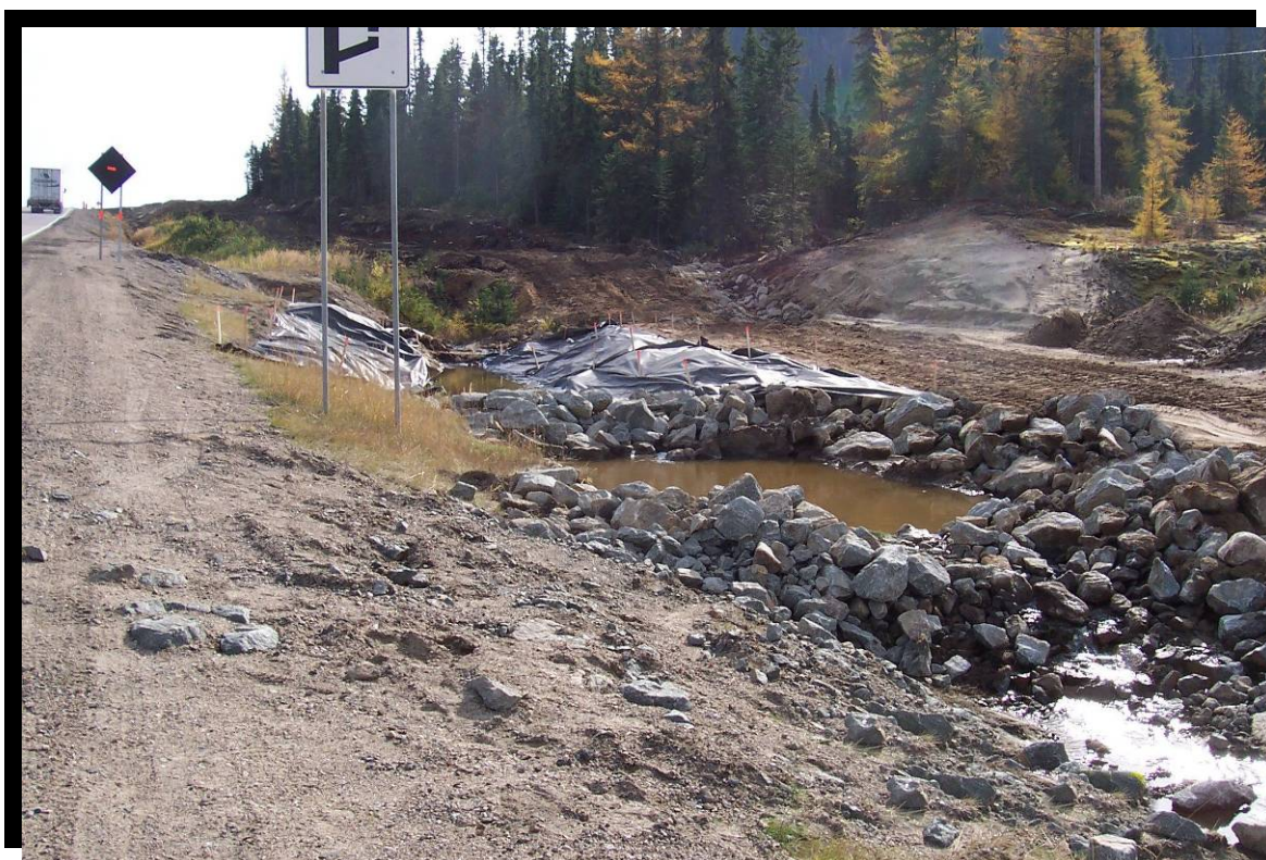
FIGURE 141 Stabilisation temporaire d'un fossé avec membrane géotextile en amont d'une berme filtrante et d'une trappe à sédiments. Empierrement du talus d'un chemin d'accès à un ponton en construction. Route 175 dans la réserve faunique des Laurentides, au kilomètre 149, secteur de la rivière Pikauba. (2004.1095)
