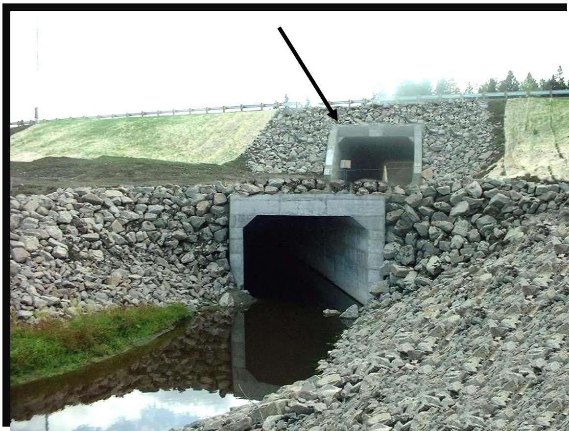
FIGURE 17 Autoroute 70 à Jonquière, secteur du ruisseau Jean-Dechêne. (2001.1014) Structure pour la traverse des motoneiges , ponceau rectangulaire de 6 m de largeur sur 4 m de hauteur et 69 m de longueur avec platelage de bois. Cette structure a été conçue pour le passage d'une surfaceuse de sentier de motoneige pouvant mesurer jusqu'à 3,38 m (11 pieds - 1 pouce) de largeur sur 3,10 m (10 pieds - 2 pouces) de hauteur et 12,45 m (40 pieds - 10 pouces) de longueur. (Composante véhicules hors route du milieu humain)
