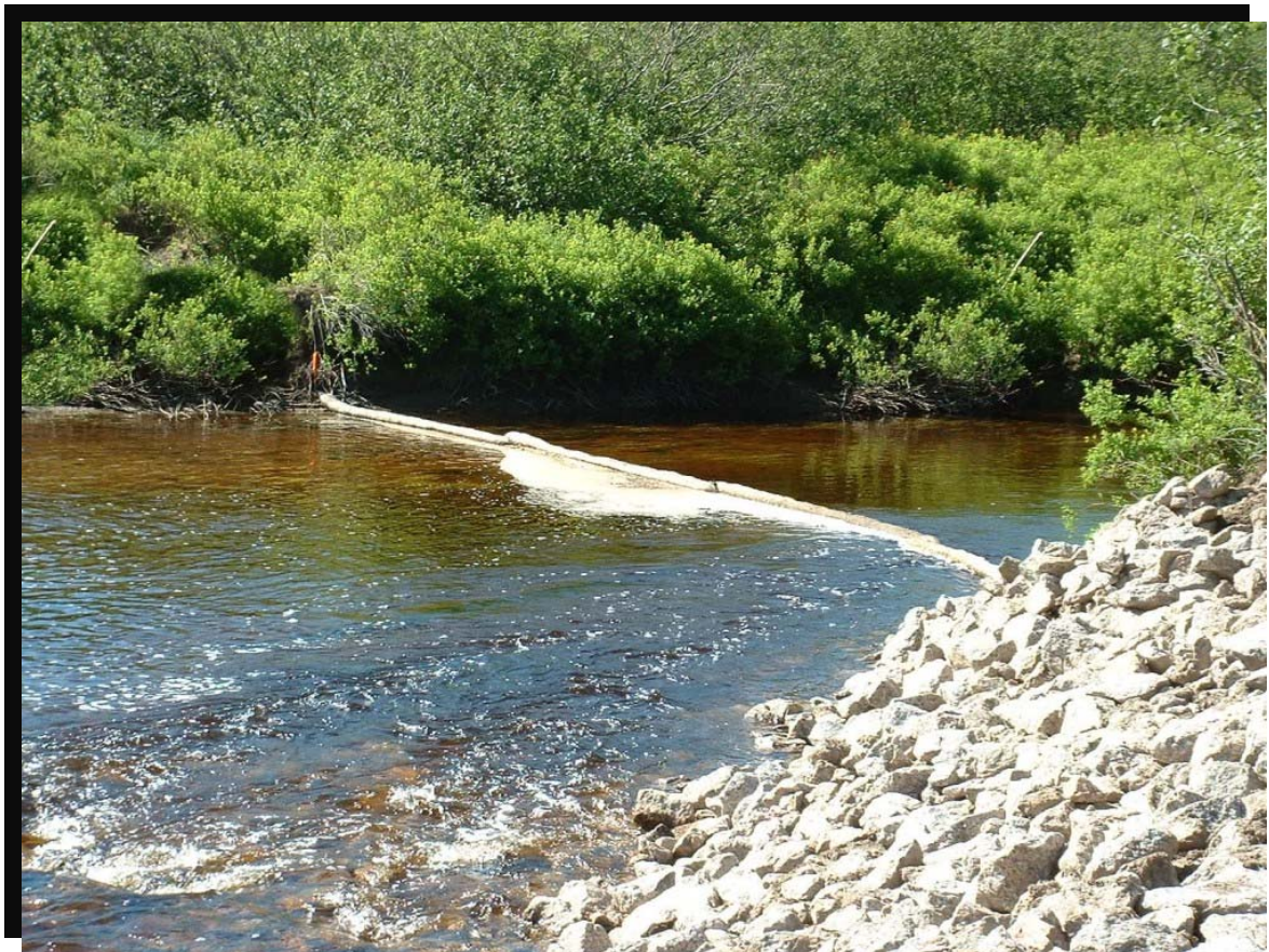
FIGURE 40 Utilisation d'une estacade flottante en aval du pont en construction. Route 169 dans la réserve faunique des Laurentides, au kilomètre 48, rivière Morin. (2002.1047)
