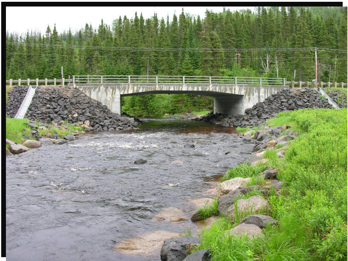
FIGURE 91 Portique à dalle épaisse sur semelles, au-dessus de la rivière Sawine. Reconstitution du lit du cours d'eau. Engazonnement et plantation sur les bandes riveraines. Route 169 dans la réserve faunique des Laurentides, au kilomètre 43. (2002.1106)
