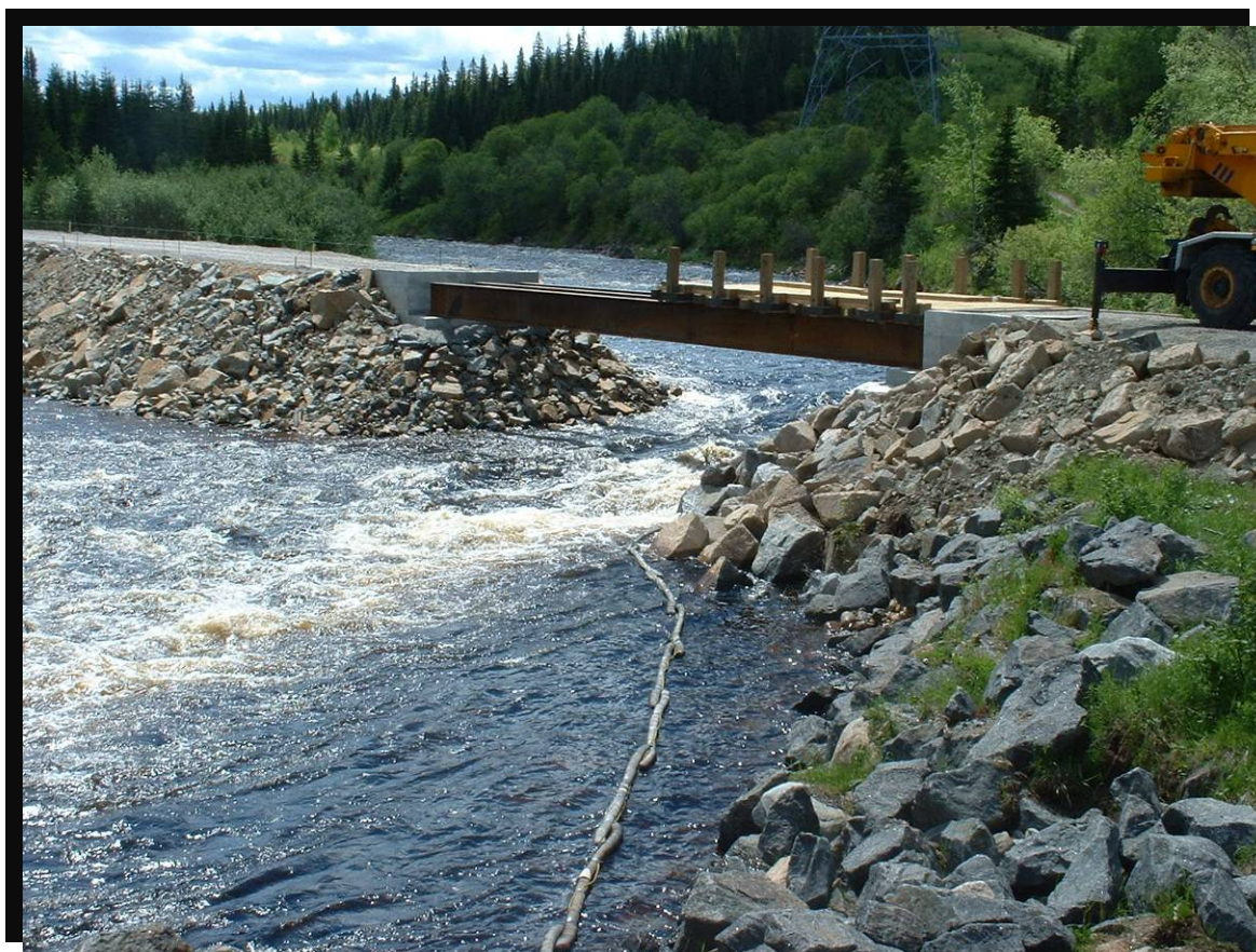
FIGURE 78 Chemin de déviation temporaire au-dessus de la rivière Pikauba. Construction d'un pont temporaire acier-bois sur culées de béton. Stabilisation des remblais par empierrement et installation d'une estacade flottante. Route 169 dans la réserve faunique des Laurentides, au kilomètre 13. (2004.1134)
