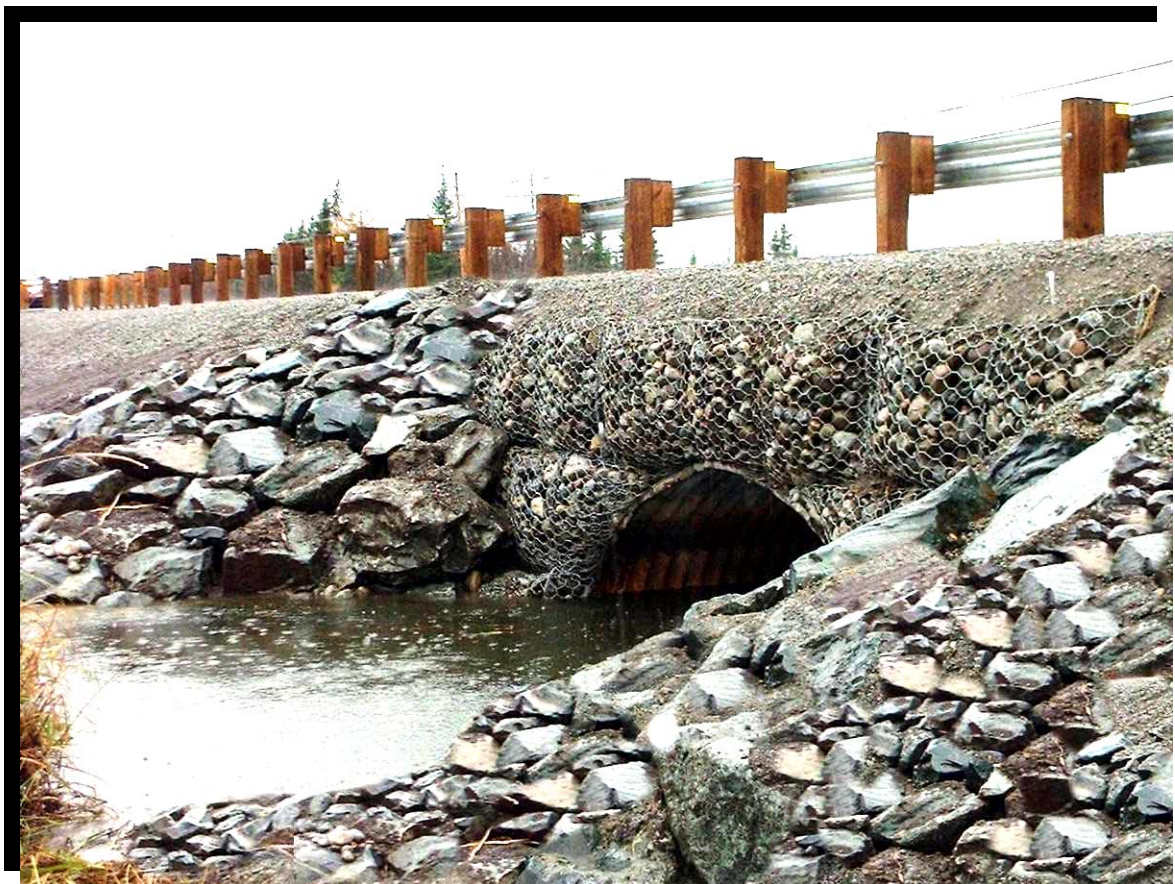
FIGURE 25 Route 167 à Chibougamau, ruisseau David. (2001.1023) Construction d'un mur de soutènement constitué d'un mur poids en gabions afin d'éviter d'empiéter dans l'habitat du poisson. (Composante ichtyofaune du milieu naturel biologique)
