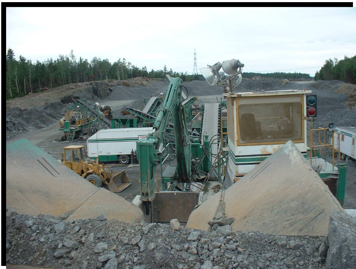
FIGURE 45 Activités de concassage dans l'emprise de l'autoroute en construction. Autoroute 70 à Jonquière, à l'ouest du pont de la rivière aux Sables. (2002.1125)
