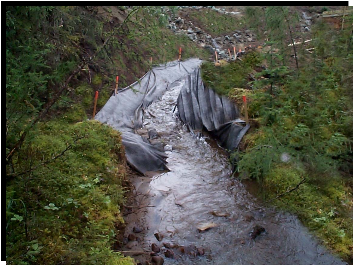
FIGURE 72 Canal de dérivation temporaire sur membrane. Route 175 dans la réserve faunique des Laurentides, au kilomètre 151, secteur de la rivière Pikauba. (2004.1099)
