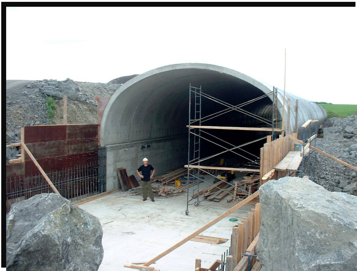
FIGURE 19 Autoroute 70 à Jonquière, secteur du rang Saint-Benoît. (2002.1016) Structure pour la traverse de la machinerie agricole , ponceau voûté d'une longueur de 65 m dont le gabarit permet les dégagements minimums suivants : dégagement de 1,83 m (6 pieds) de hauteur sur 6,40 m (21 pieds) de largeur pour permettre le passage du tablier d'une moissonneuse-batteuse et dégagement de 5,18 m (17 pieds) de hauteur sur 4,27 m (14 pieds) de largeur pour permettre le passage de la cabine. (Composante agriculture du milieu humain)
