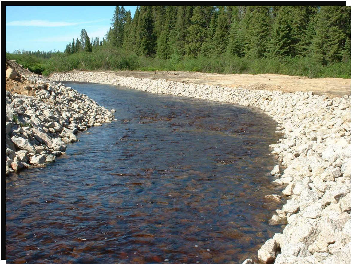
FIGURE 71 Canal de dérivation temporaire de la rivière Morin pour la construction d'un pont. Stabilisation du lit et des berges par empierrement. Route 169 dans la réserve faunique des Laurentides, au kilomètre 48. (2002.1098)
