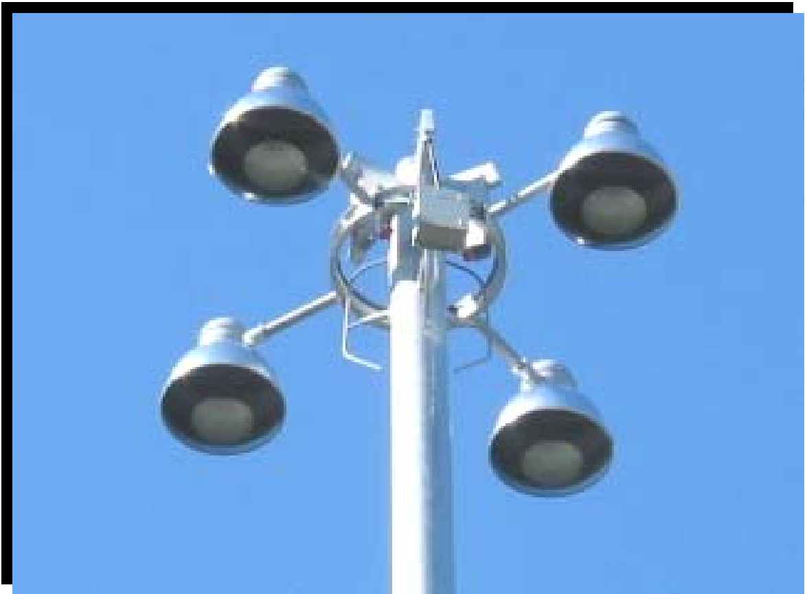
FIGURE 29 Autoroute 70 à Jonquière, secteur du carrefour Mathias-Mellon, rue Lesage. (2003.1029) Afin d'atténuer la pollution lumineuse aux abords d'un quartier résidentiel, les luminaires de 8 hauts mâts d'éclairage le long de l'autoroute ont été dotés d'un anneau noir (louvre) qui permet de diriger les faisceaux lumineux de manière appropriée. (Composante pollution lumineuse du milieu humain)
