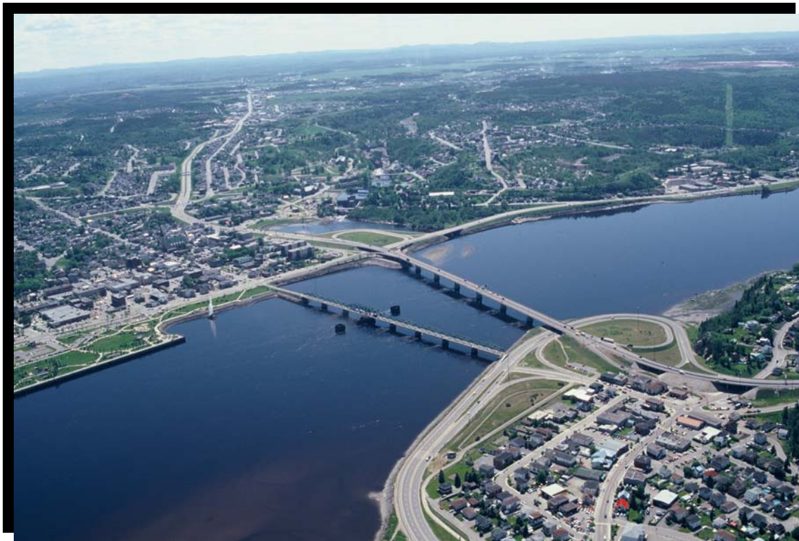
FIGURE 85 Pont à poutres-caissons en acier avec 6 piliers dans la rivière Saguenay. À droite, pont Dubuc à 4 voies, Saguenay (arrondissement de Chicoutimi). (2002.1194)
