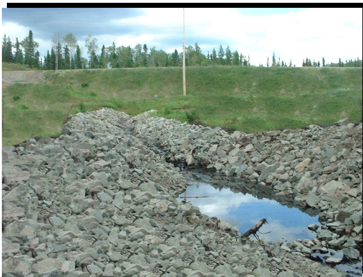
FIGURE 158 Le réaménagement des mares salines implique parfois la construction d'un bassin de sédimentation ou d'infiltration permanent lorsque les travaux sont localisés à proximité du milieu hydrique. Route 169 dans la réserve faunique des Laurentides, au kilomètre 47, près de la rivière Morin. (2001.1173)
