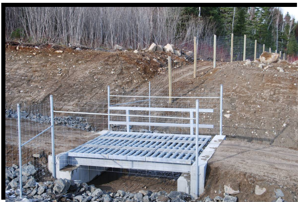
Figure 162 Photo prise au chantier pendant l'installation d'une section de clôture métallique d'une hauteur de 2,4 m. La clôture est raccordée à un passage anticervidés de type 1, construit dans le chemin d'accès forestier du secteur Lecompte. Route 175 dans la réserve faunique des Laurentides, au kilomètre 206,6. (2007.1192)
