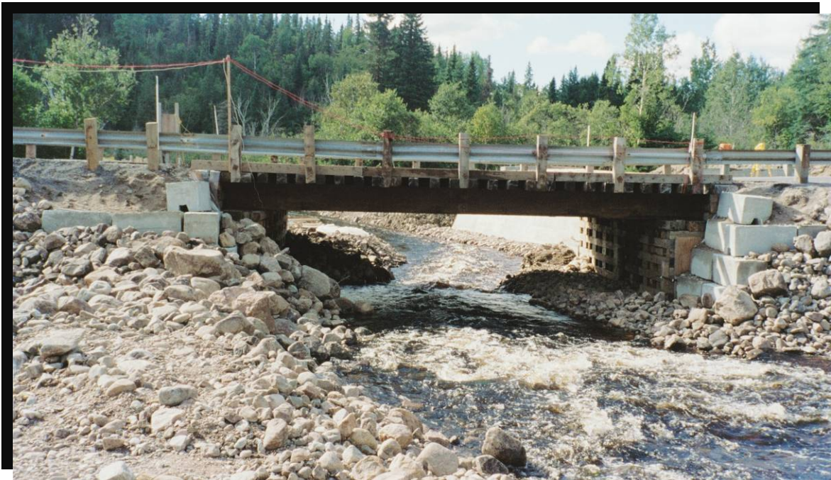
FIGURE 76 Chemin de déviation temporaire au-dessus de la rivière des Commissaires ou Quaquakamaksis. Construction d'un pont temporaire acier-bois sur caissons de bois. Stabilisation des talus du chemin par empierrement. Route 155 à Lac-Bouchette. (2001.1135)
