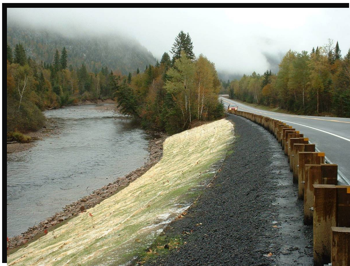
FIGURE 60 Remblai pour l'élargissement de l'accotement et la pose de glissières de sécurité. - Aménagement paysager du remblai de pierre : terre végétale, engazonnement avec matelas de fibre de bois et plantation de frênes rouges, de vinaigriers, de myriques baumiers et d'érables de l'Amur. Espace de 1 m entre les plants. - Aménagement d'un patron de plantation répété tous les 25 m, en considération du statut panoramique de la route, de la façon suivante : 10 m (engazonnement) - 5 m (plantation) - 5 m (engazonnement) - 5 m (plantation). Route 172 dans le canton Durocher, au kilomètre 64,7, rivière Sainte-Marguerite. (2002.1066)
