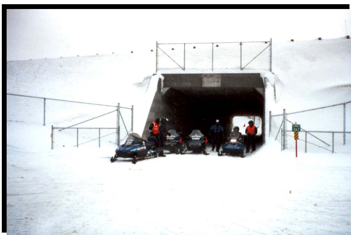
FIGURE 18 Autoroute 70 à Jonquière, secteur du ruisseau Jean-Dechêne. (2002.1015) Structure pour la traverse des motoneiges . (Voir commentaires de la figure précédente) Photo du Club de motoneigistes du Saguenay inc.
