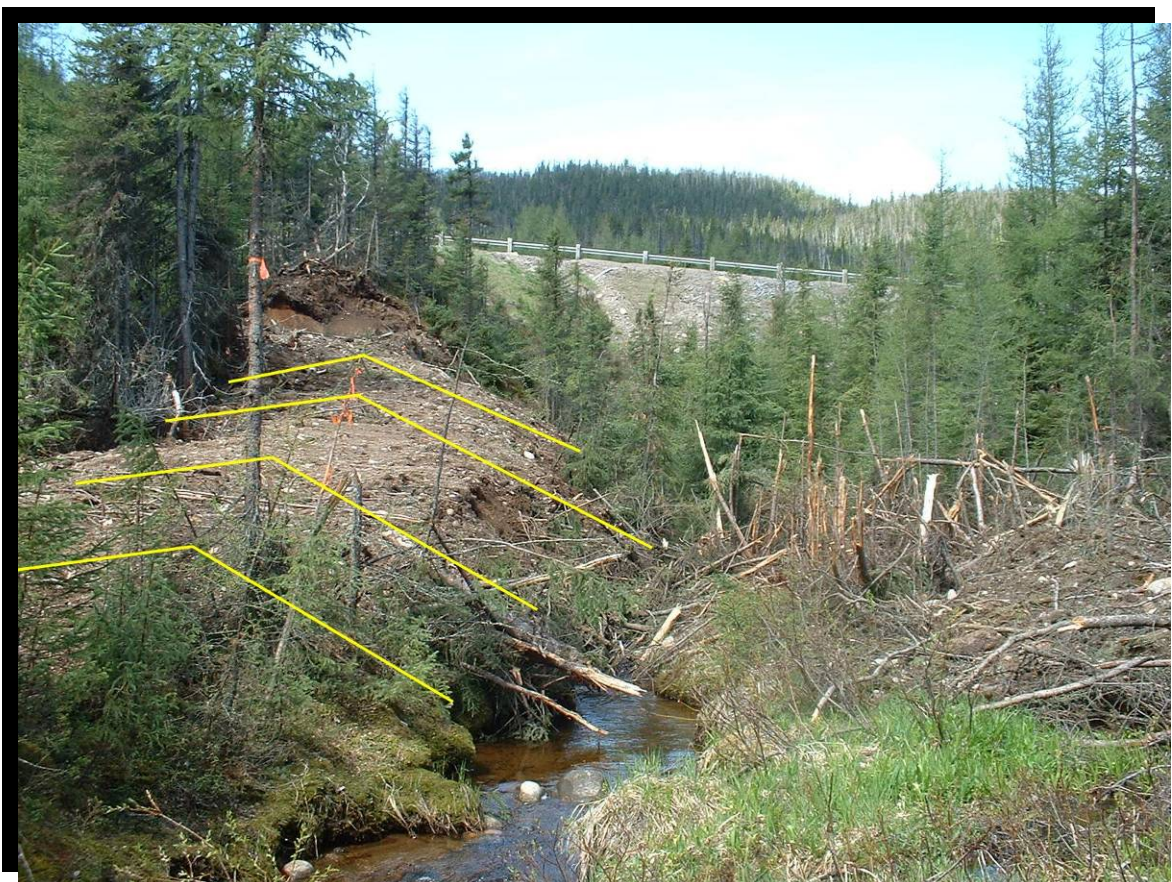
FIGURE 32 Patron de réaménagement d'un site perturbé après les opérations d'étude des sols. Route 175, réserve faunique des Laurentides, secteur de la rivière Pikauba, au kilomètre 151,6. (2004.1057)
