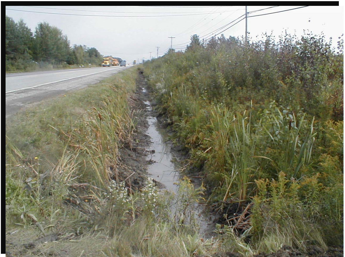
FIGURE 118 Nettoyage d'un fossé par la méthode du tiers inférieur. (0000.1150)
