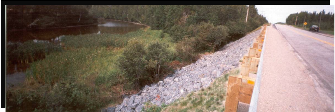
FIGURE 57 Remblai pour l'élargissement de l'accotement et la pose de glissières de sécurité. Protection de la végétation existante au pied du talus en bande riveraine Route 169 à Péribonka, en bordure de la rivière Moreau. (1998.1064)
