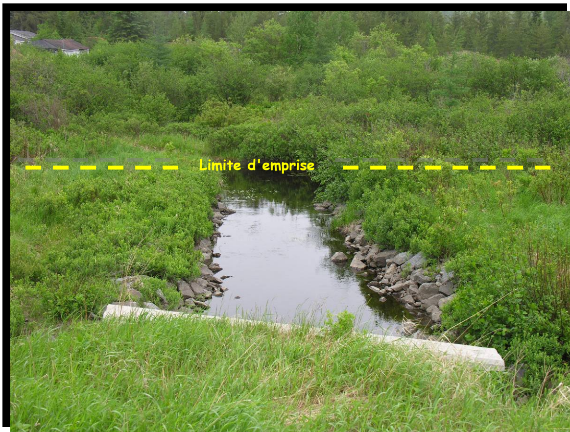
FIGURE 95 Ponceau rectangulaire en béton armé (PBA) dans la rivière Dorval. Stabilisation par empierrement et reconstitution du lit du cours d'eau. Engazonnement et plantation des bandes riveraines jusqu'à la limite de l'emprise. Route 170 à Larouche. (2005.1142)
