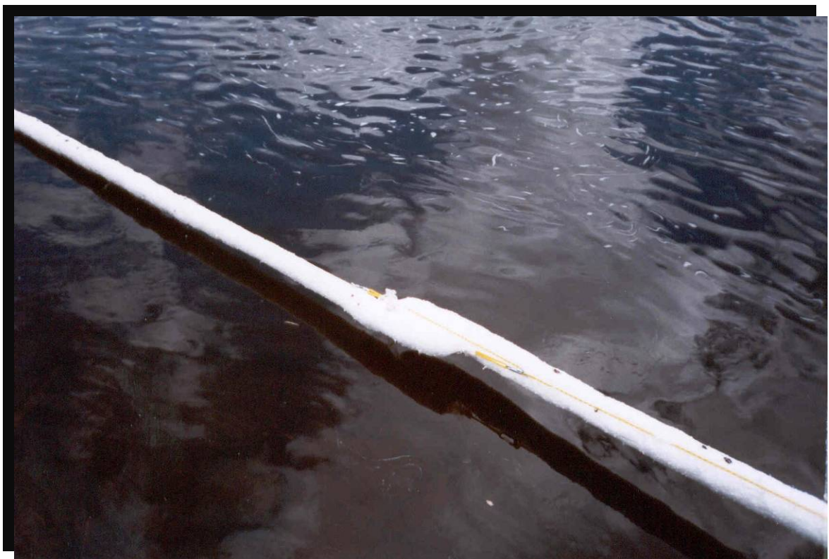
FIGURE 41 Vue rapprochée d'une estacade flottante en aval du pont en construction. Route 169 dans la réserve faunique des Laurentides, au kilomètre 52, rivière aux Écorces. (1999.1048)
