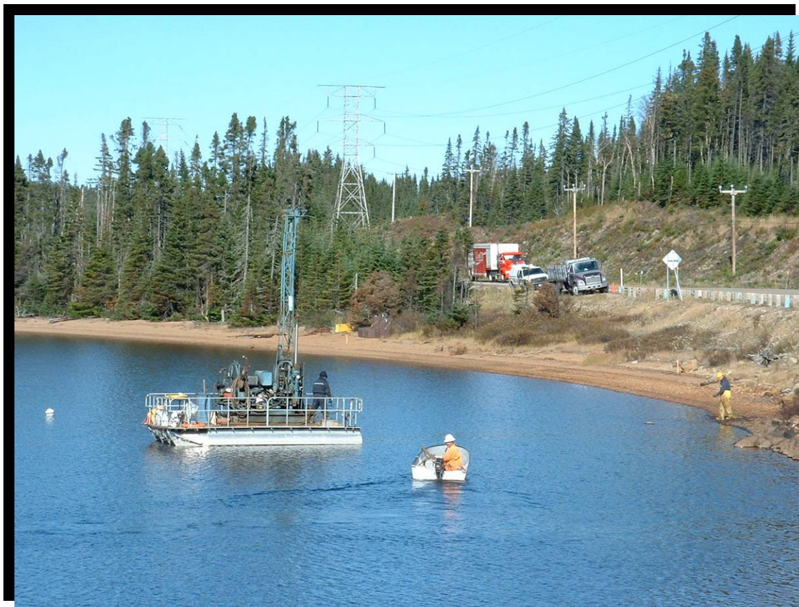
FIGURE 30 Étude du lit du lac Sept-Îles pour la construction d'une route. Route 175, dans la réserve faunique des Laurentides, au kilomètre 129. (2003.1055)
