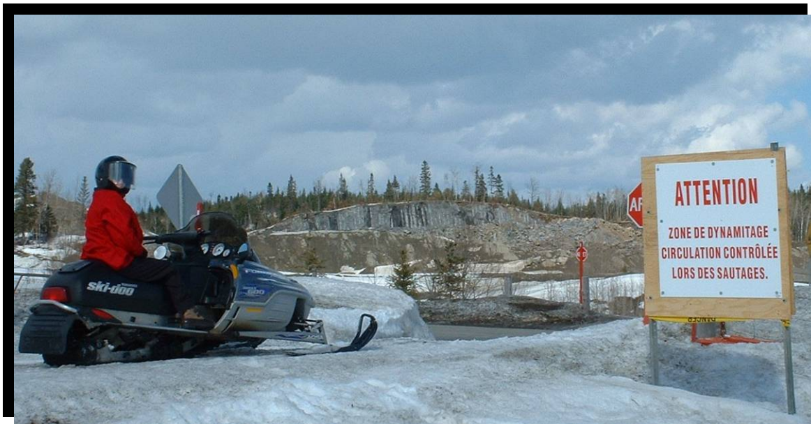
FIGURE 167 Signalisation dans un sentier de motoneige aux abords du chantier. Autoroute 70 à Jonquière. (2002.1165)
