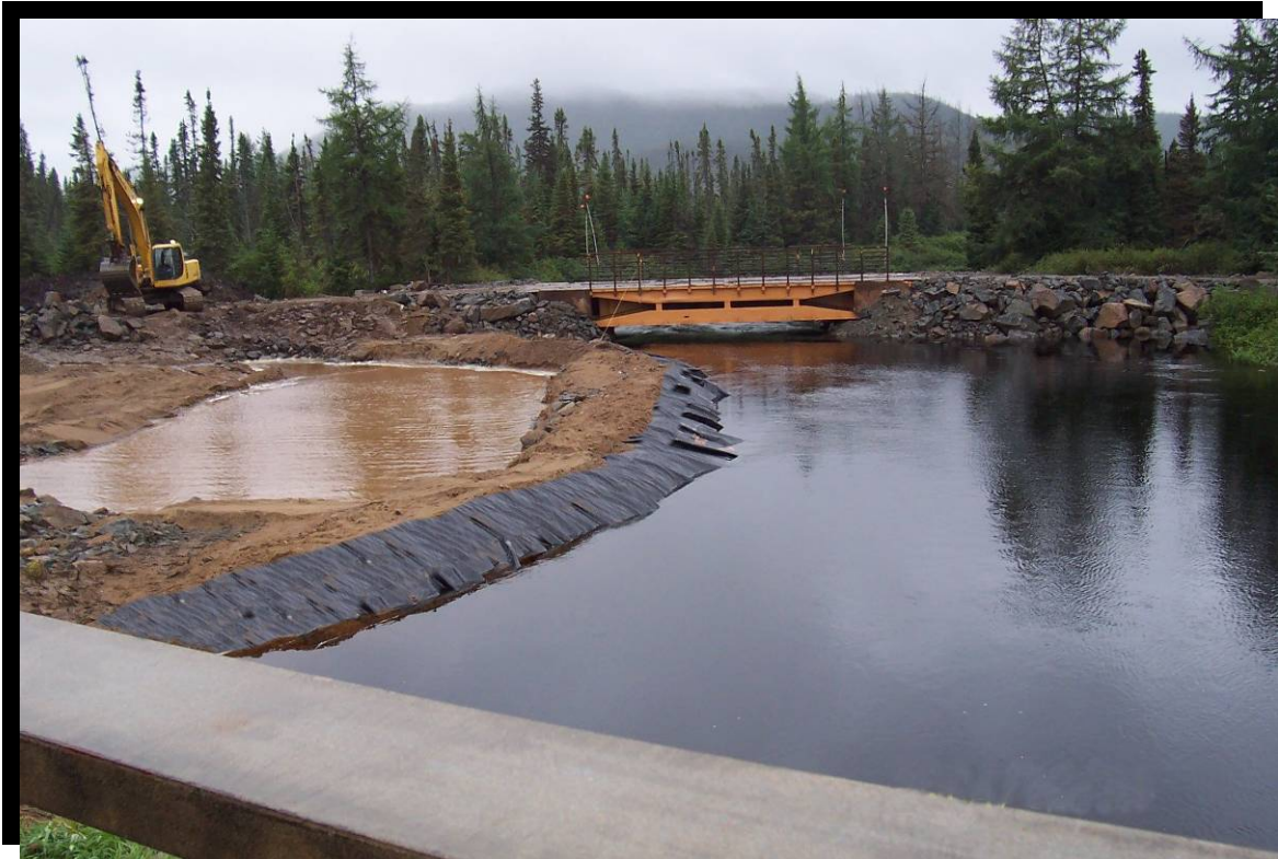
FIGURE 81 Batardeau aménagé dans la rivière Pikauba pour la construction d'une culée de pont. Matériaux utilisés : sols dont les pentes sont stabilisées à l'aide d'une membrane imperméable. Route 175 dans la réserve faunique des Laurentides, au kilomètre 149. (2004.1138)
