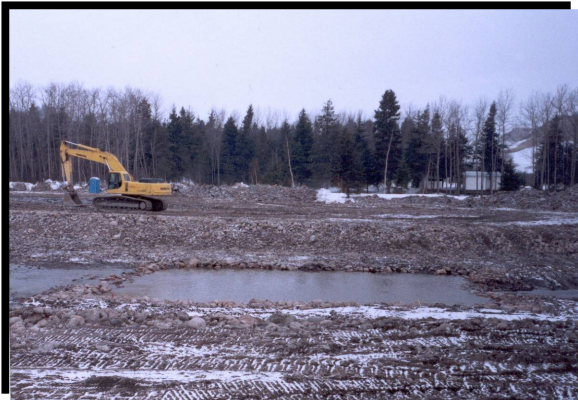
FIGURE 149 Construction d'une fosse à saumons dans la rivière à Mars reconstituée après le déluge des 19 et 20 juillet 1996. La Baie. (1997.1129)
