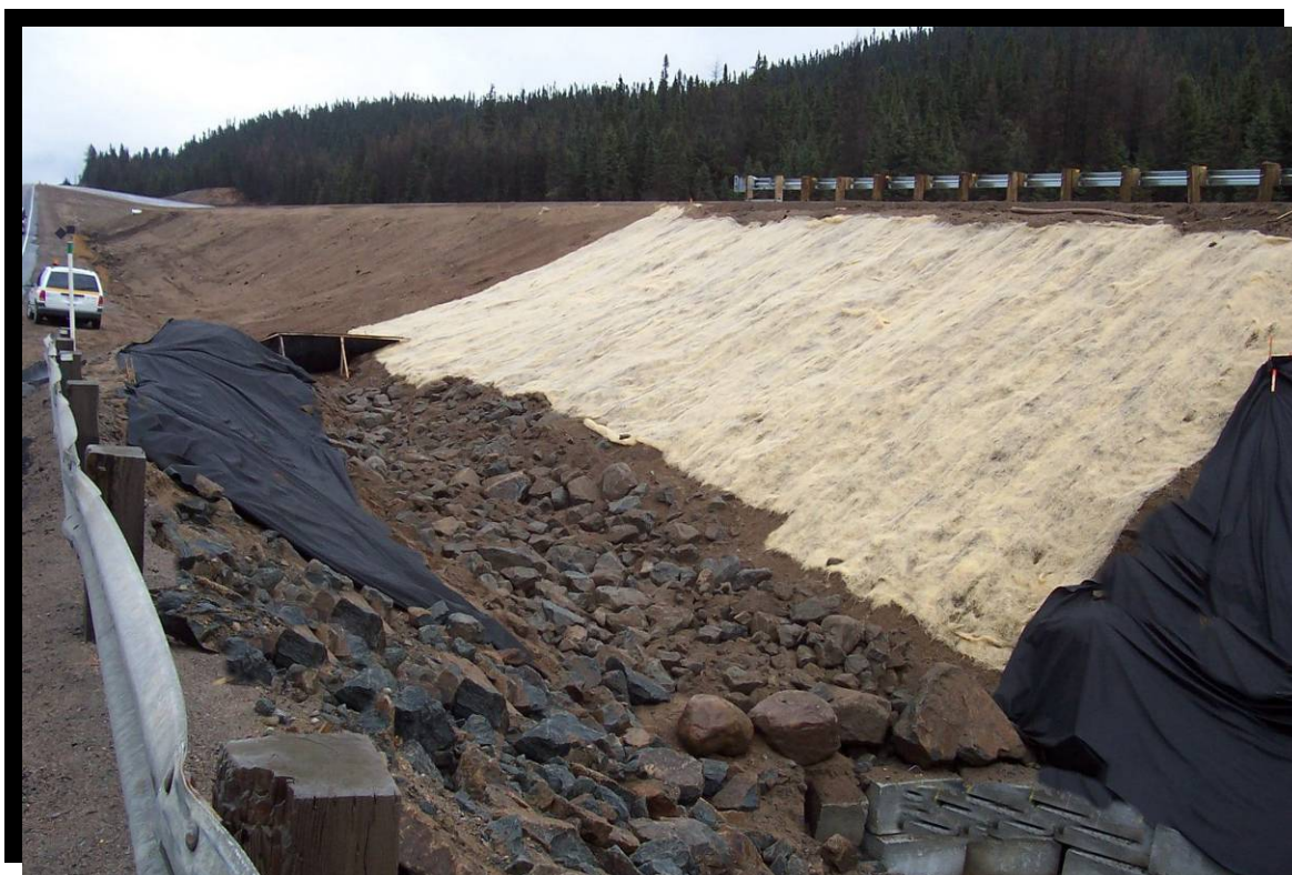
FIGURE 142 Stabilisation temporaire avec membrane géotextile, matelas de fibre de bois et barrière à sédiments pour suspension des travaux durant l'hiver. Route 175 dans la réserve faunique des Laurentides, au kilomètre 151, secteur de la rivière Pikauba. (2004.1078)
