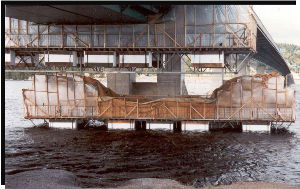
FIGURE 110 Enceinte de confinement pour le décapage (sablage) par projection d'abrasifs (dans ce cas, des billes d'acier ont été utilisées) et peinture des poutres-caissons en acier. Pont Dubuc au-dessus de la rivière Saguenay à Chicoutimi. (1994.1152)
