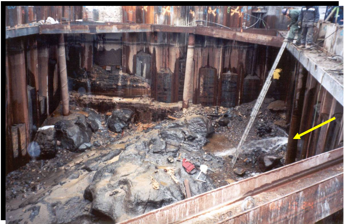
FIGURE 84 Batardeau aménagé dans la rivière La Grande Décharge pour la construction d'un pilier. Infiltration d'eau qui nécessite l'étanchement des palplanches d'acier par injection de béton. Route 169 à Alma. (2002.1141)
