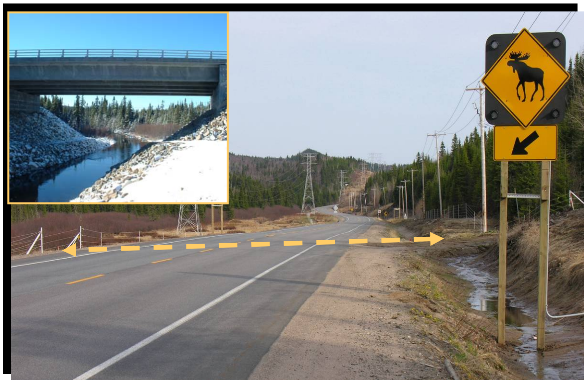
FIGURE 160 Passage pour la grande faune sur la chaussée de la route 169 (kilomètre 33) dans un secteur avec clôture électrique sur 10 km. Route à 2 voies à faible débit. Au coin gauche, passage pour la grande faune sous la chaussée de la route 175, au kilomètre 178, dans un secteur avec clôture électrique sur 5 km. Réserve faunique des Laurentides. (2005.1168)
