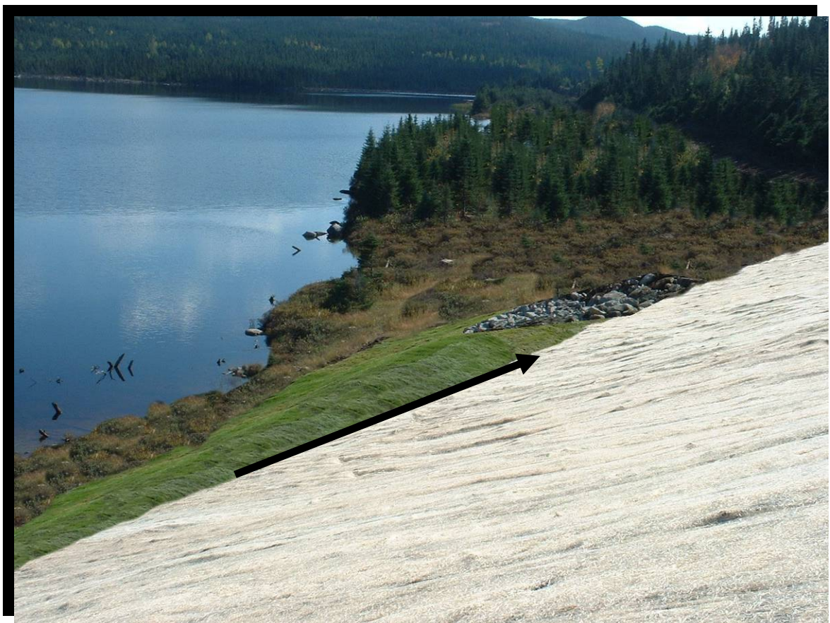
FIGURE 56 Construction d'un fossé de pente dans un talus de remblai. Route 175 dans la réserve faunique des Laurentides, du kilomètre 176 au kilomètre 180, secteur du lac Tourangeau. (2002.1039)
