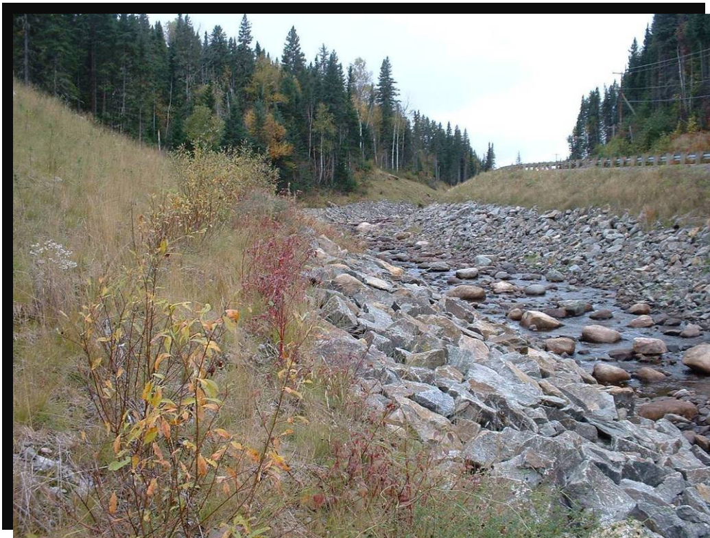
Figure 69 Déplacement d'un cours d'eau pour la reconstruction d'une route. - Stabilisation des sols par la technique de plantation : fagots et matelas de branches confectionnés avec des branches de cornouillers stolonifères, le tout mis en place sur une couche de terre végétale d'une épaisseur minimale de 200 mm. La terre végétale peut être remplacée par du terreau ou du compost. - Dans ce cas, le diamètre des branches prélevées pour la confection des fagots varie de 15 mm à 25 mm et la longueur varie de 1 500 mm à 2 000 mm. Le diamètre des branches prélevées pour la confection du matelas de branches varie de 15 mm à 30 mm et la longueur varie de 1 200 mm à 1 500 mm. - Le matelas de branches est recouvert de terre végétale et d'une natte de jute et fixé contre le sol avec des fils métalliques galvanisés. - Les travaux de végétalisation sont exécutés au printemps ou à l'automne mais idéalement l'automne. Route 381 à Ferland-et-Boilleau, rivière Bras d'Hamel. (1999.1072)
