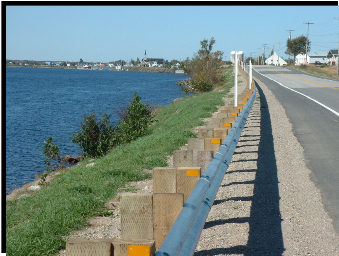
FIGURE 59 Remblai pour l'élargissement de l'accotement et la pose de glissières de sécurité. Protection de la végétation existante au pied du talus en bande riveraine et engazonnement. Route 169 à Péribonka en bordure de la rivière Péribonka. (2001.1002)
