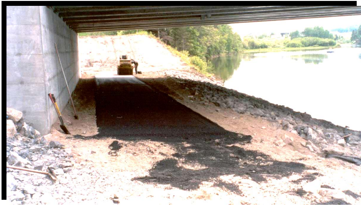
FIGURE 15 Autoroute 70 à Jonquière. (2001.1013) Aménagement d'une piste cyclable sous le pont de la rivière aux Sables. (Composante vélo du milieu humain)
