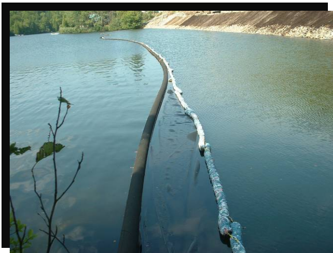
FIGURE 139 Utilisation d'un rideau de confinement retenu au fond de l'eau au droit de travaux de remblai dans le lac Bouchard. Membrane cousue sur un tuyau flottant en surface et attachée à une chaîne étalée sur le lit du cours d'eau. Route 172 à Sainte-Rose-du-Nord. (2005.1182)
