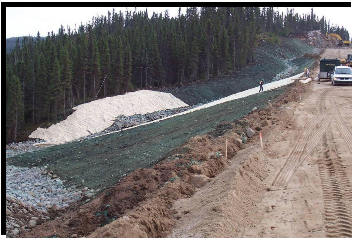
FIGURE 146 Stabilisation immédiate et permanente des talus et fossés au droit d'un ponceau. Empierrement des fossés, du ponceau et du lit du cours d'eau. Engazonnement et matelas de fibre de bois. Route 175 dans la réserve faunique des Laurentides, au kilomètre 149, secteur de la rivière Pikauba. (2004.1084)
