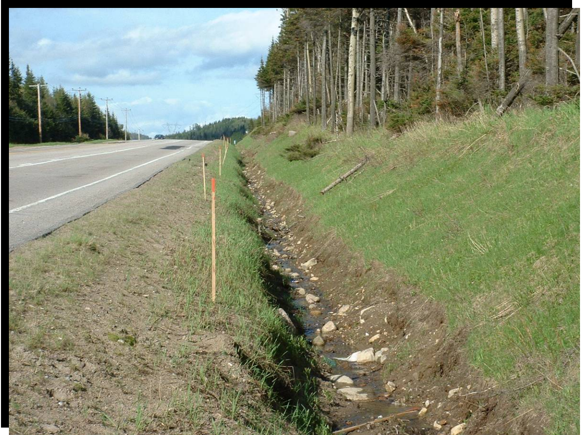
FIGURE 117 Nettoyage d'un fossé par la méthode du tiers inférieur. (0000.1149)
