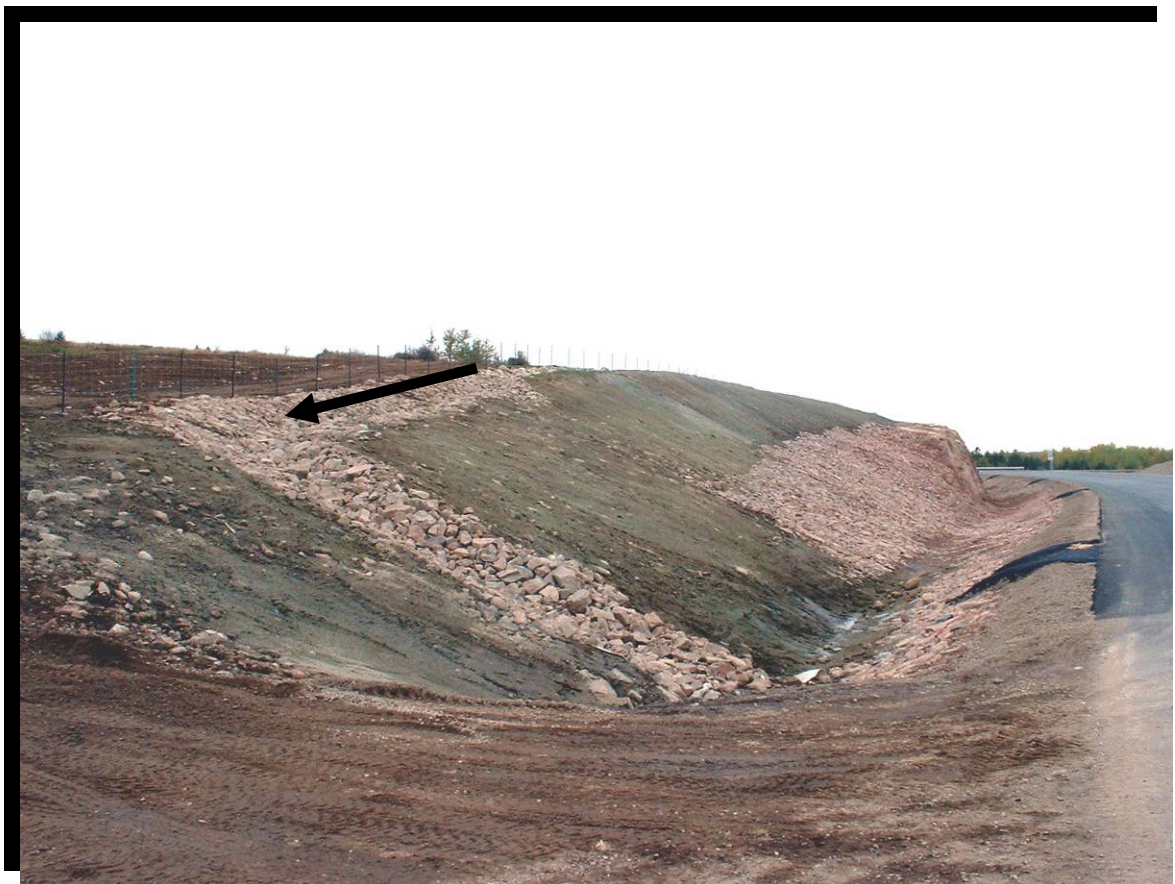
FIGURE 55 Construction d'un fossé de crête et empierrement dans un talus de déblai. Route 155 à Saint-François-de-Sales. (2002.1038)
