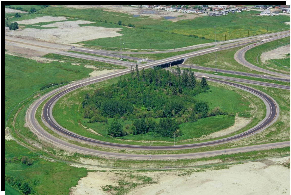
Figure 13 Autoroute 70 à Jonquière, carrefour Saint-Hubert. (2002.1006) Protection d'un îlot boisé. (Composantes végétation et avifaune du milieu naturel biologique et composante paysage du milieu humain)
