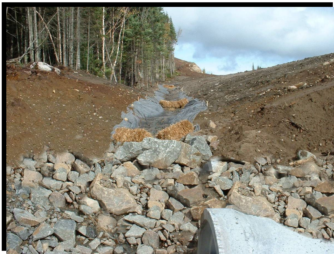
FIGURE 140 Stabilisation temporaire d'un fossé en construction avec membrane géotextile et ballots de paille. L'extrémité du ponceau est empierrée immédiatement de façon permanente. Route 175 dans la réserve faunique des Laurentides, au kilomètre 189, secteur du lac des Uries. (2003.1090)
