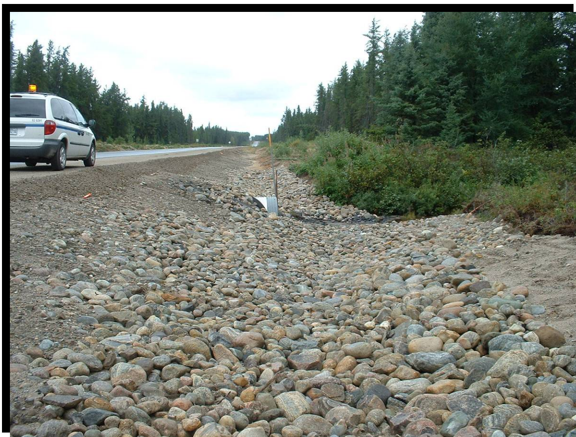
FIGURE 112 Empierrage des fossés sur une longueur de 30 m à partir de la LNHE du cours d'eau. Route 167 dans la réserve faunique Ashuapmushuan, du kilomètre 122 au kilomètre 129, secteur des cantons Lorne et Denaut. (2002.1144)
