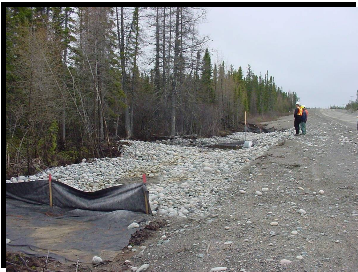
FIGURE 135 Utilisation de barrières géotextiles dans un fossé. Chemin d'accès au village des Cris d'Oujé-Bougoumou, Nord-du-Québec. (2004.1092)
