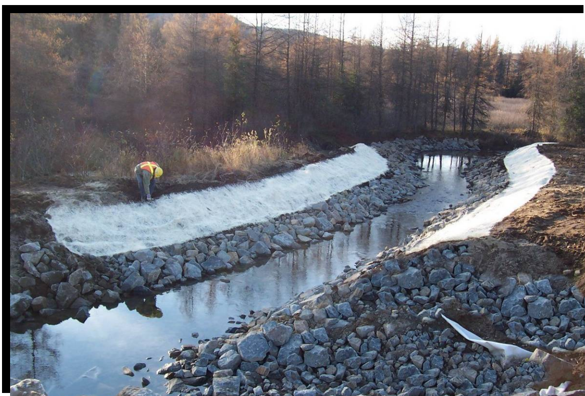
FIGURE 147 Stabilisation immédiate et permanente de la bande riveraine au droit d'un ponceau. Empierrement des fossés, du ponceau et du lit du cours d'eau. Engazonnement et matelas de fibre de bois. Route 175 dans la réserve faunique des Laurentides, au kilomètre 149, secteur de la rivière Pikauba. (2004.1085)
