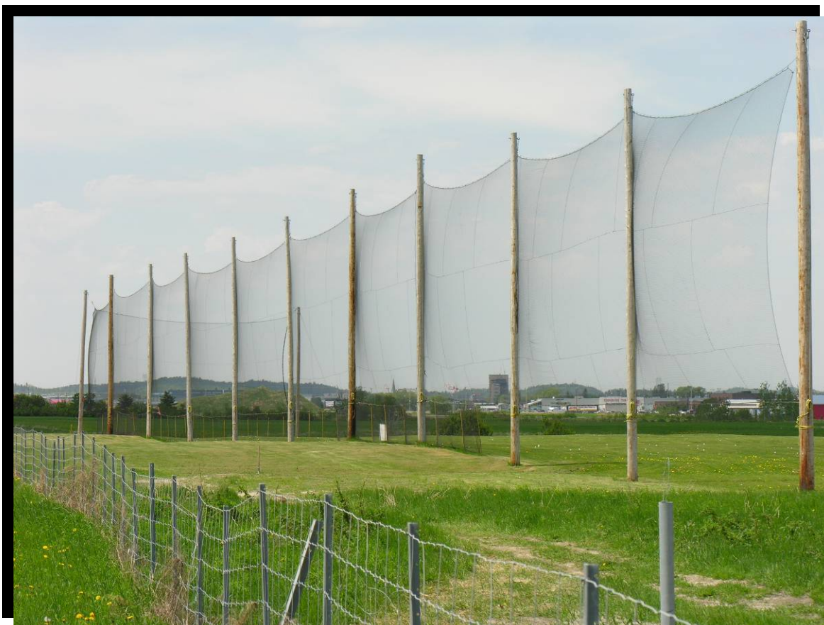
FIGURE 168 Filet trappe pour les balles de golf placé à l'extrémité d'un club de pratique en bordure de la clôture d'emprise. Environ 7,6 m de hauteur sur 120 m de longueur. Autoroute 70 à Jonquière. (2005.1124)
