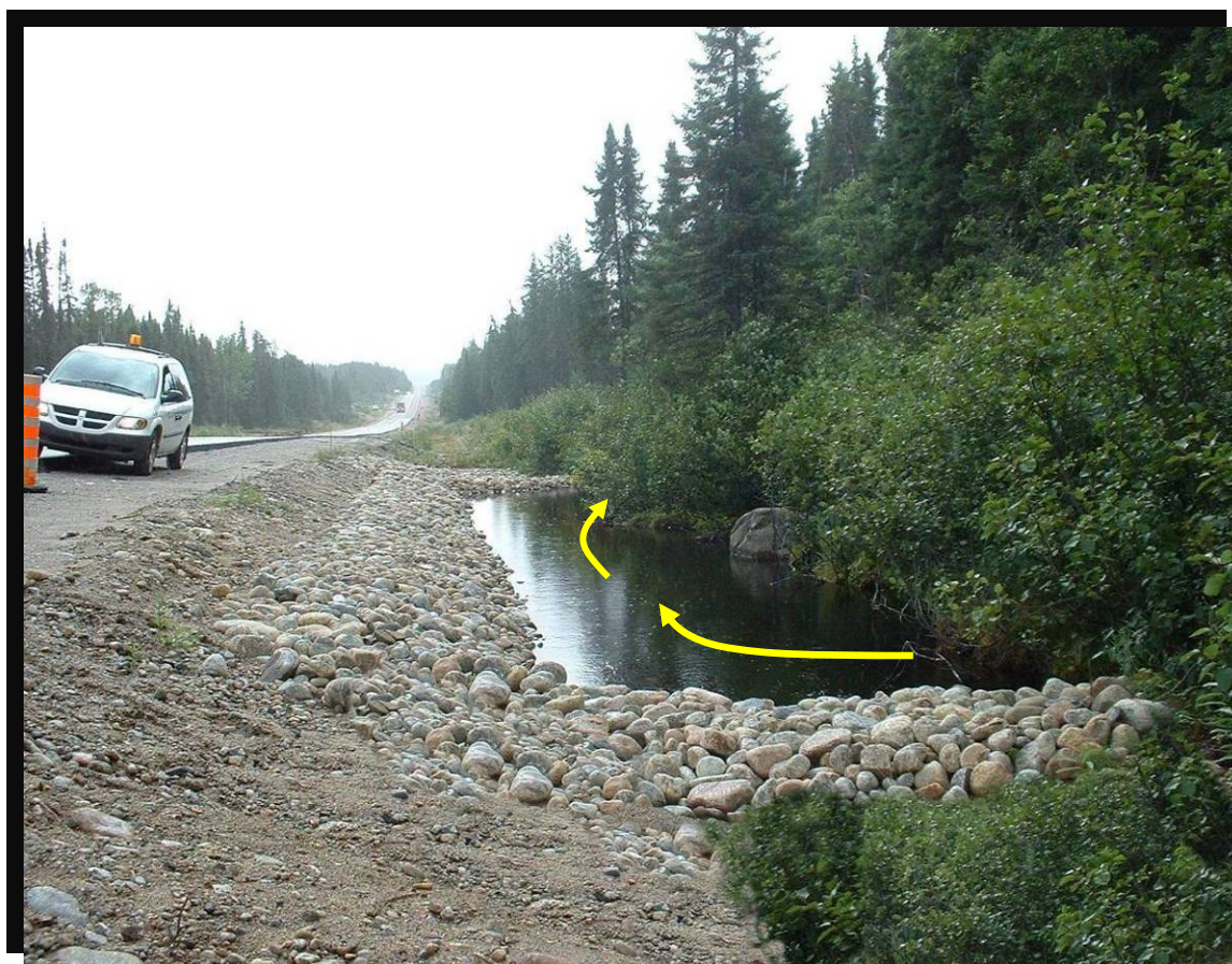
FIGURE 62 Remblai pour l'élargissement de l'accotement. Empierrement du talus de la route en bande riveraine d'un méandre de cours d'eau. Route 167 dans la réserve faunique Ashuapmushuan, du kilomètre 122 au kilomètre 129, secteurs des cantons Lorne et Denaut. (2002.1068)
