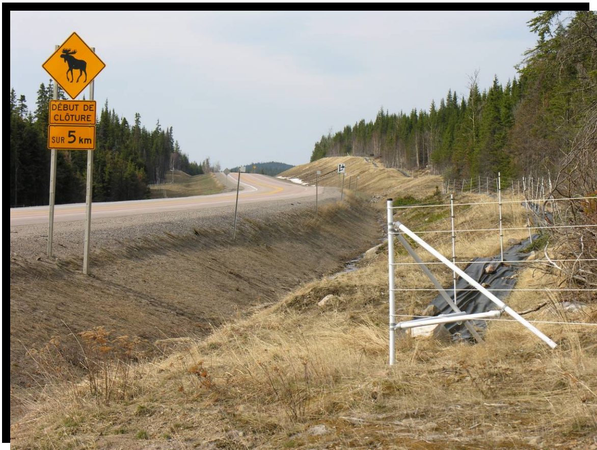
FIGURE 159 Clôture électrique (hauteur de 1,5 m) et panneau de signalisation surdimensionné avec panonceaux, dans l'emprise de la route 175, du kilomètre 175 au kilomètre 180. Réserve faunique des Laurentides, secteur du lac Tourangeau. (2005.1170)
