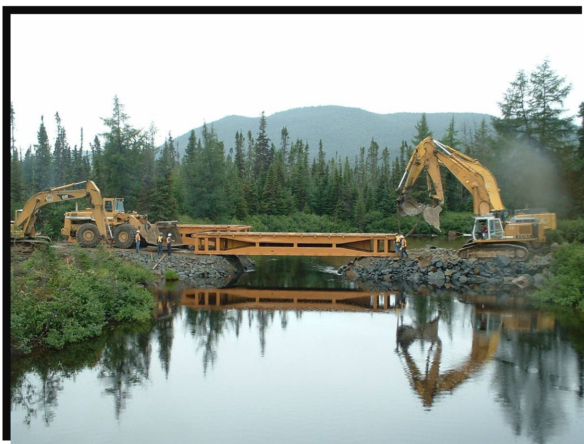
FIGURE 80 Pont temporaire au-dessus de la rivière Pikauba pour le transport de roc dynamité. Remblai d'approche en pierre et tablier construit avec des wagons de train. Route 175 dans la réserve faunique des Laurentides, au kilomètre 149. (2004.1137)
