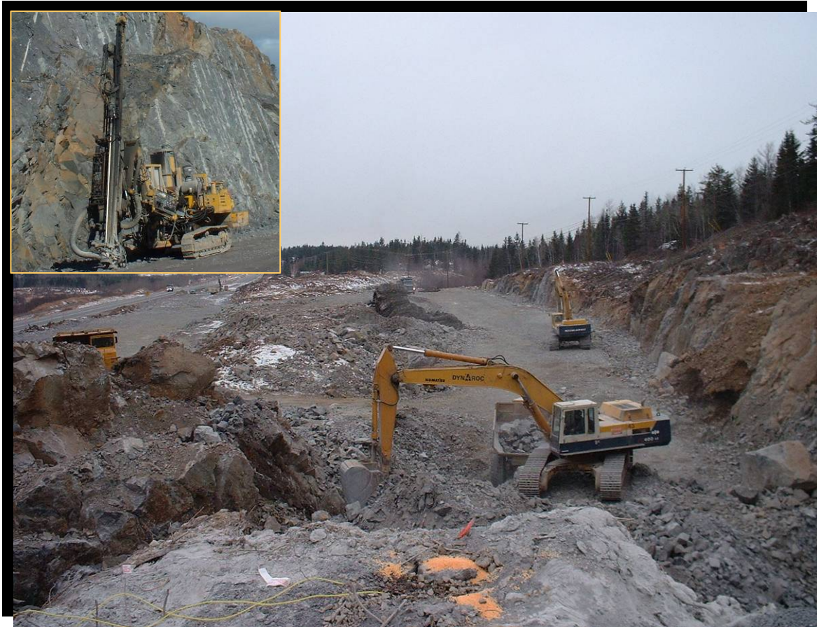
FIGURE 49 Travaux de déblai de première classe (dynamitage de roc). Au coin gauche, foreuse. Autoroute 70 à Jonquière, secteur de La Ratière au droit du carrefour dénivelé du rang Saint-Benoît. (2001.1075)
