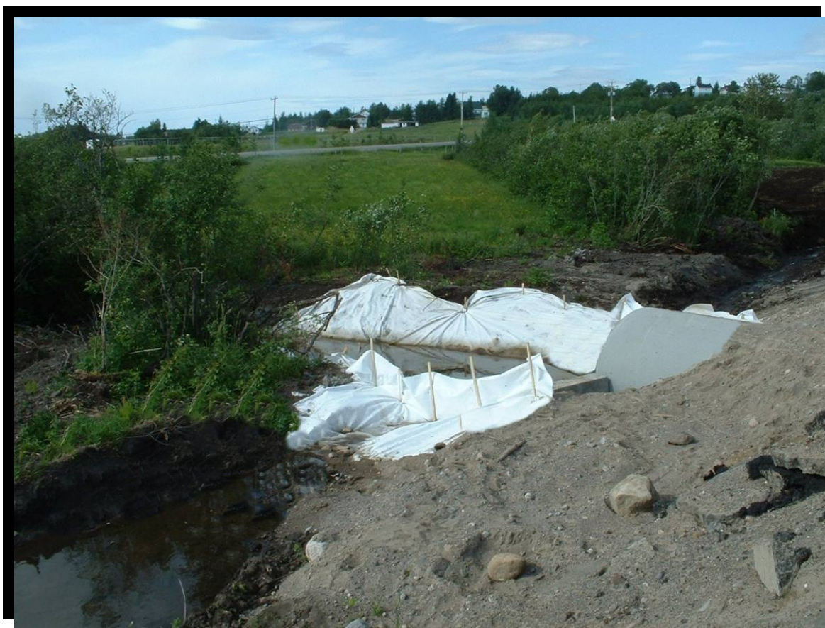
FIGURE 136 Utilisation de barrières géotextiles dans un fossé. Route 155 à Saint-François-de-Sales. (2002.1030)
