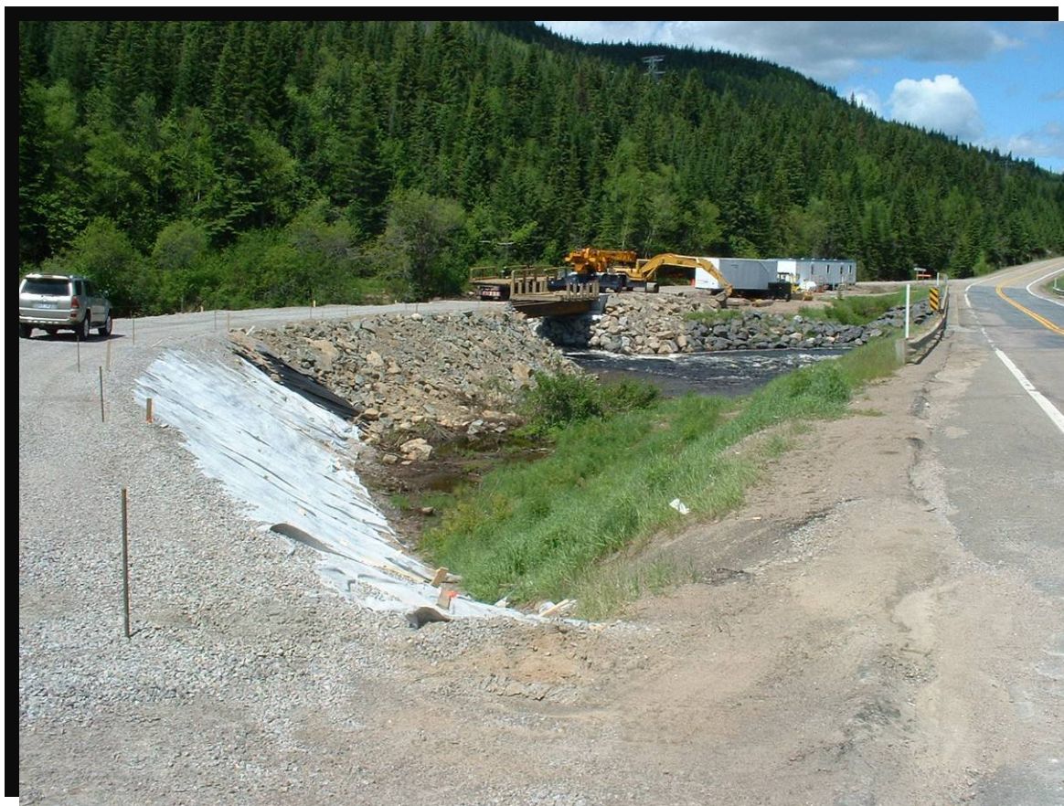
FIGURE 77 Chemin de déviation temporaire au-dessus de la rivière Pikauba. Stabilisation des talus du chemin par empierrement dans la section du cours d'eau et à l'aide d'une membrane géotextile dans la section de la bande riveraine. Conservation de la végétation (filtre naturel) en aval des fossés. Route 169 dans la réserve faunique des Laurentides, au kilomètre 13. (2004.1133)
