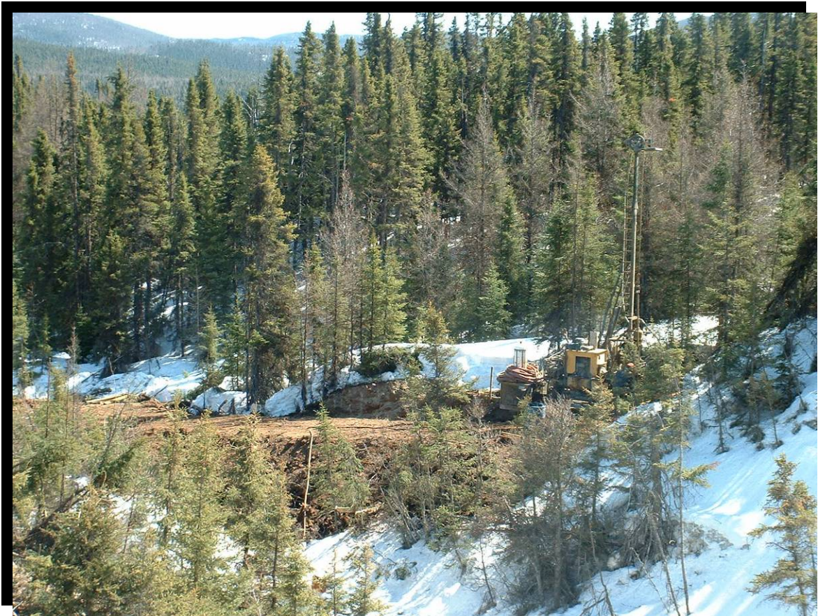
FIGURE 31 Étude des sols pour la construction d'un ponceau. Route 175, réserve faunique des Laurentides, secteur de la rivière Pikauba, au kilomètre 151,6. (2004.1056)
