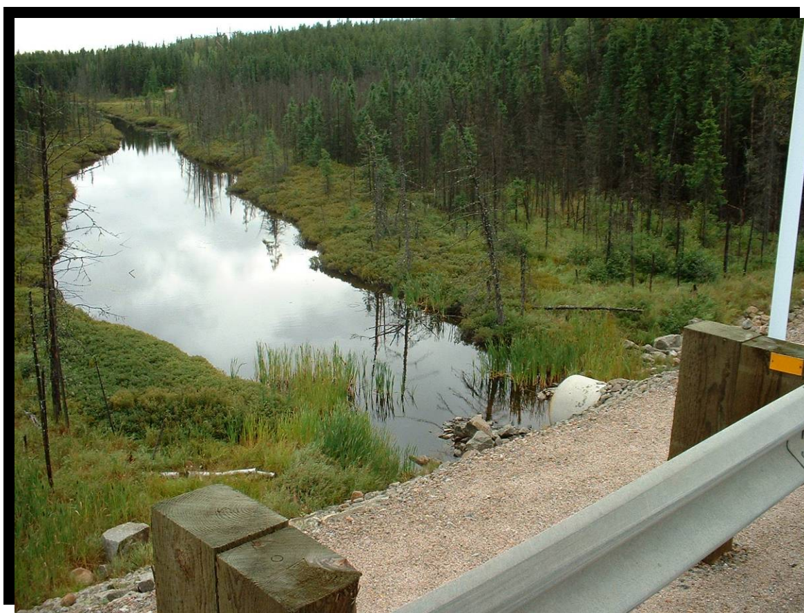
FIGURE 99 Ponceau circulaire en béton armé (TBA) dans l'émissaire du lac du Cran. Les bandes riveraines en aval du ponceau ont été protégées pendant les travaux. Route 167 dans la réserve faunique Ashuapmushuan, au kilomètre 46. (2002.1114)
