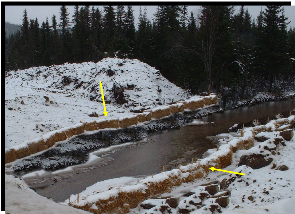
FIGURE 129 Filtres en ballots de paille le long d'un cours d'eau. Route 175 dans la réserve faunique des Laurentides, du kilomètre 176 au kilomètre 180, secteur du lac Tourangeau. (2001.1037)
