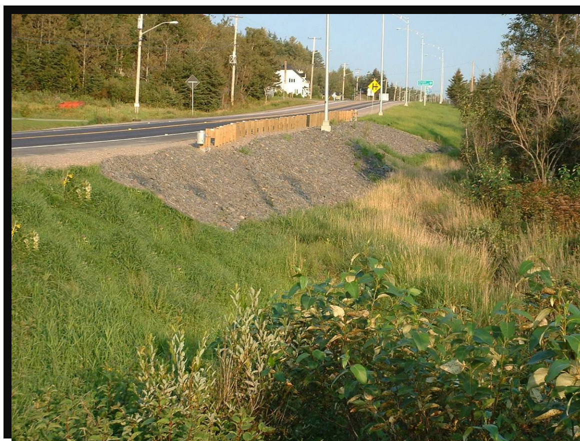
FIGURE 64 Remblai pour l'élargissement de l'accotement et pose de glissières de sécurité. Après travaux correctifs. Empierrement et engazonnement du talus de la route en bande riveraine d'un cours d'eau. (0000.1070)
