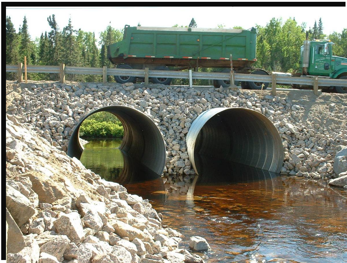
FIGURE 79 Chemin de déviation temporaire au-dessus de la rivière Morin détournée. Aménagement de ponceaux en parallèle. Stabilisation des extrémités de ponceaux de type TTOG par empierrement et enfouissement pour assurer le libre passage du poisson. Route 169 dans la réserve faunique des Laurentides, au kilomètre 48. (2002.1136)
