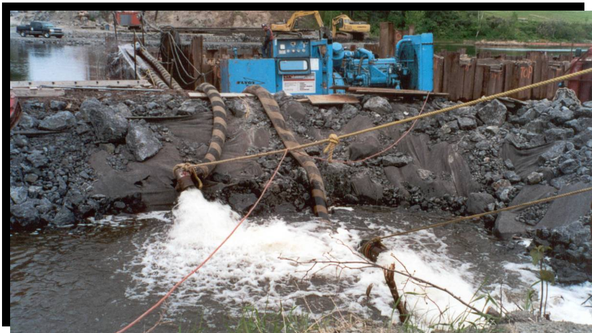
FIGURE 123 Bassin de sédimentation. Autoroute 70 à Jonquière, pont de la rivière aux Sables. (2000.1035)
