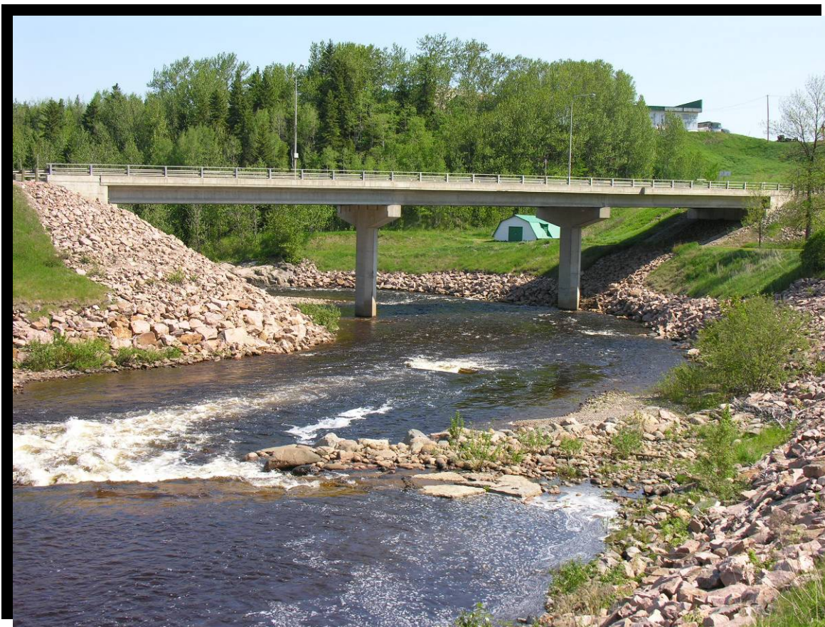
FIGURE 86 Pont à poutres de béton avec 2 piliers. Reconstitution du lit du cours d'eau. Engazonnement et plantation sur les bandes riveraines. Route 381 à La Baie, rivière à Mars. (2005.1103)
