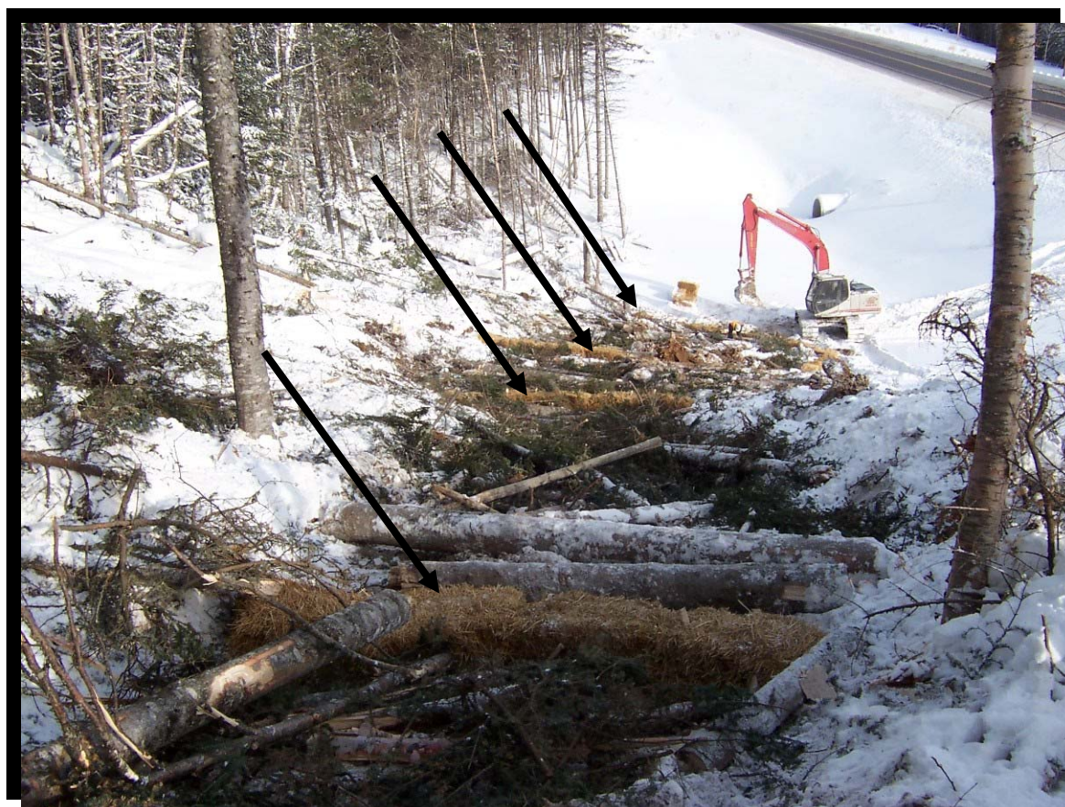
Figure 34 Chemin d'accès pour l'étude des sols. Mesures de protection contre l'érosion à l'aide de filtres en ballots de paille. Route 175, réserve faunique des Laurentides, secteur du lac des Uries, au kilomètre 189. (2005.1187)
