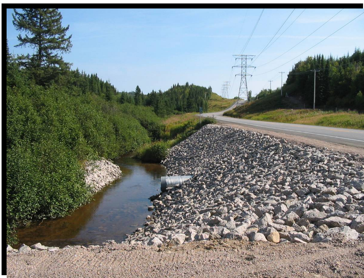
FIGURE 102 Partie de ponceau circulaire en acier (TTOG) pour rallonger un ponceau existant. Stabilisation par empierrement de l'extrémité du ponceau, du talus de la route, du lit du cours d'eau et de la bande riveraine opposée au ponceau. Route 169 dans la réserve faunique des Laurentides, au kilomètre 32. (2004.1117)
