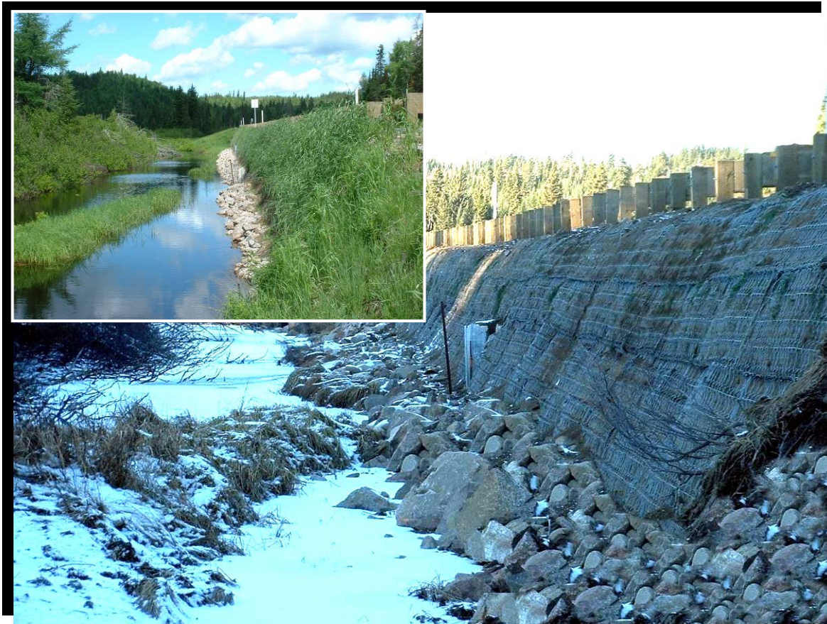
FIGURE 24 Route 169 dans la réserve faunique des Laurentides, secteur du chemin Laferté, du kilomètre 55 au kilomètre 60, rivière au Cheval. (2002.1022) Construction d'un mur de soutènement constitué d'un remblai renforcé par des géotextiles avec talus végétal, de type Terramesh, afin d'éviter d'empiéter dans l'habitat du poisson. Au coin gauche, situation en 2004. (Composante ichtyofaune du milieu naturel biologique)
