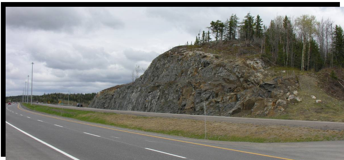
FIGURE 50 Coupe de roc avec palier. Autoroute 70 à Jonquière, secteur de La Ratière et du rang Saint-Benoît. (2005.1086)
