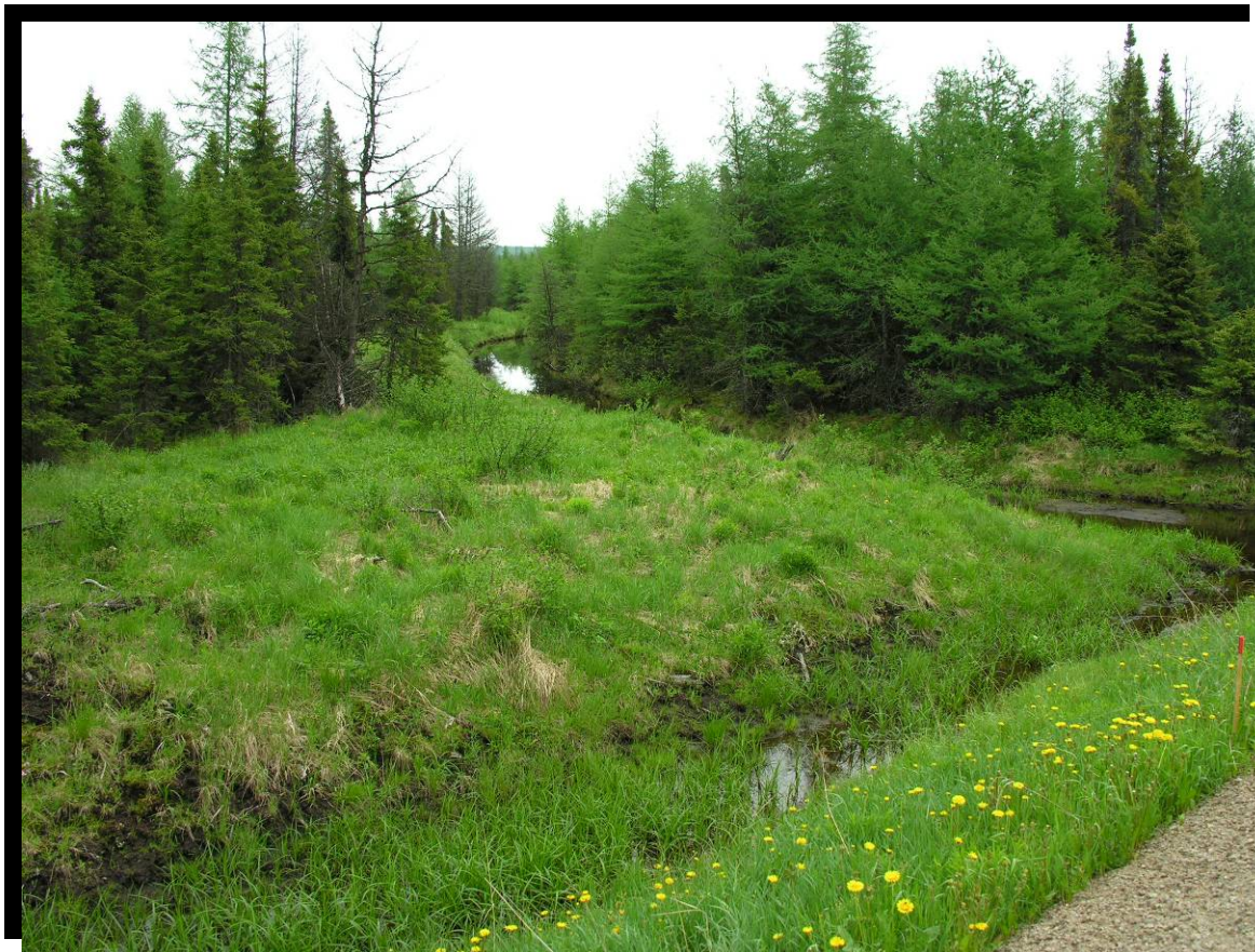
FIGURE 119 Fossé de décharge creusé vers une zone de végétation. Route 169 dans la réserve faunique des Laurentides, au kilomètre 2, près de l'intersection avec la route 175. (2005.1151)
