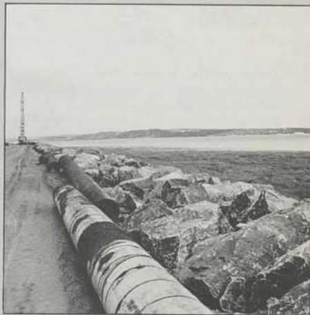
Déjà les travaux grignotent sur les riches herbiers et frayères qui caractérisent les battures de Beauport.
