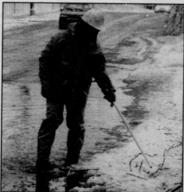
Des dizaines d'employés d'Hydro se sont affairés hier à réparer les dégâts.
