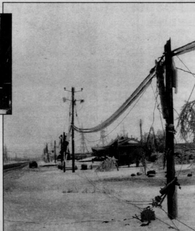
Des pylônes, il y en avait cinq ou six étêtés à la file dans les champs de Saint-Césaire faisant face au Poste de commande du réseau électrique.
