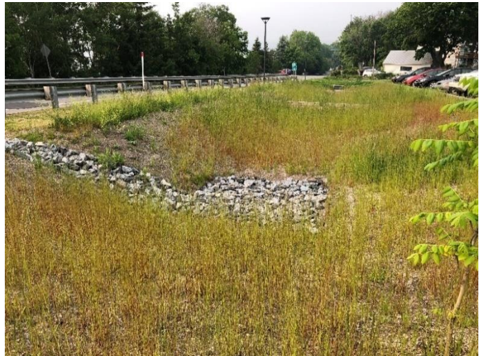
Figure 14 - Bande filtrante et aire de biorétention en bordure de route, Notre-Dame-du-Portage Mention de source : Carole Leclerc
