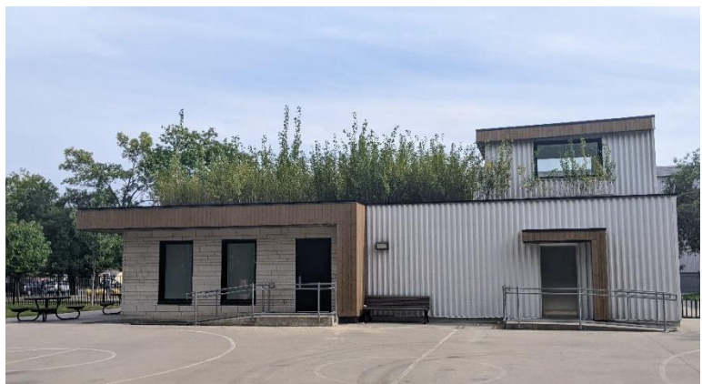
Figure 7 - Toit végétalisé du pavillon du parc Walter-Stewart, Montréal Mention de source : Vincent Bouchard
