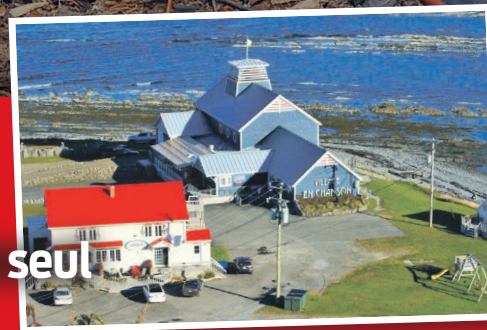
(Photo Village en chanson de Petite-Vallée)
