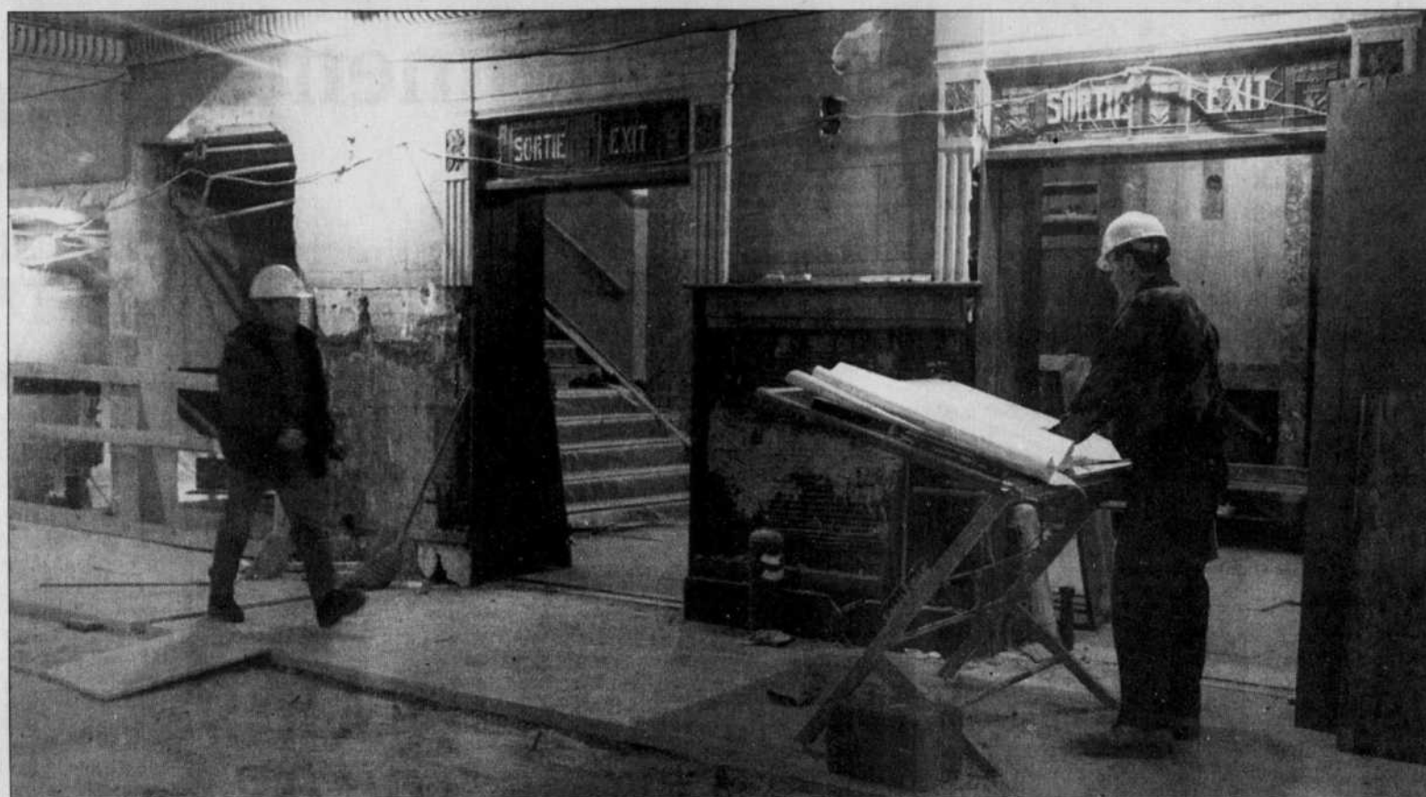
Les ouvriers ont recommencé à s'activer au Théâtre Outremont. Les travaux avaient été abandonnés en 1996. La restauration du bâtiment devrait être complétée au printemps 2001. La salle multifonctionnelle permettra d'accueillir 850 personnes.
