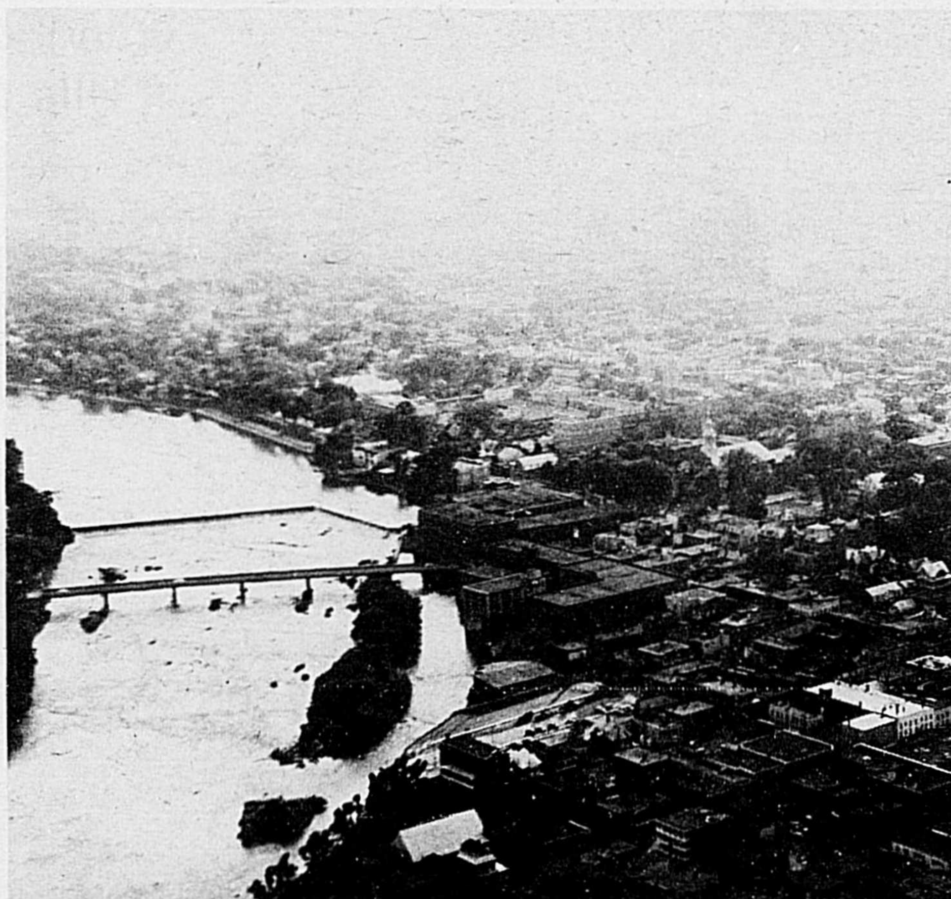
Vue aérienne du barrage actuel de la Penman's sur la rivière Yamaska. Ce barrage construit en 1916 est situé une cinquantaine de pieds en aval de l'ancien barrage qui avait été construit en 1792. Ce premier barrage actionnait le moulin à scie et à farine des seigneurs du temps situé derrière la Penman's et la rue des Cascades, à cette époque, se prolongeait jusqu'à la rue Raymond. Le canal, appelé "Lock L.-P. Morin", alimentait en eau et énergie une dizaine de petites usines logées le long de la rivière.
