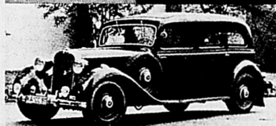
1936. La Mercedes-Benz 260D est la première voiture de tourisme diesel construite en série.
