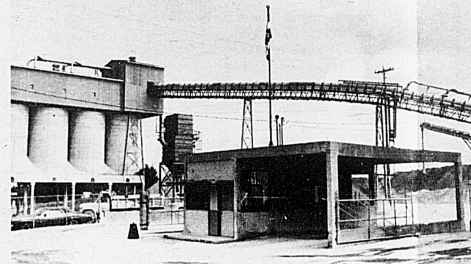
Aujourd'hui: Bureau de contrôle des poids avec système électronique. A l'arrière, l'usine de tamisage surplombant les silos emmagasinant les pierres concassées; au centre-arrière, l'un des quatre dépoussiéreurs récemment installés pour combattre la pollution.
