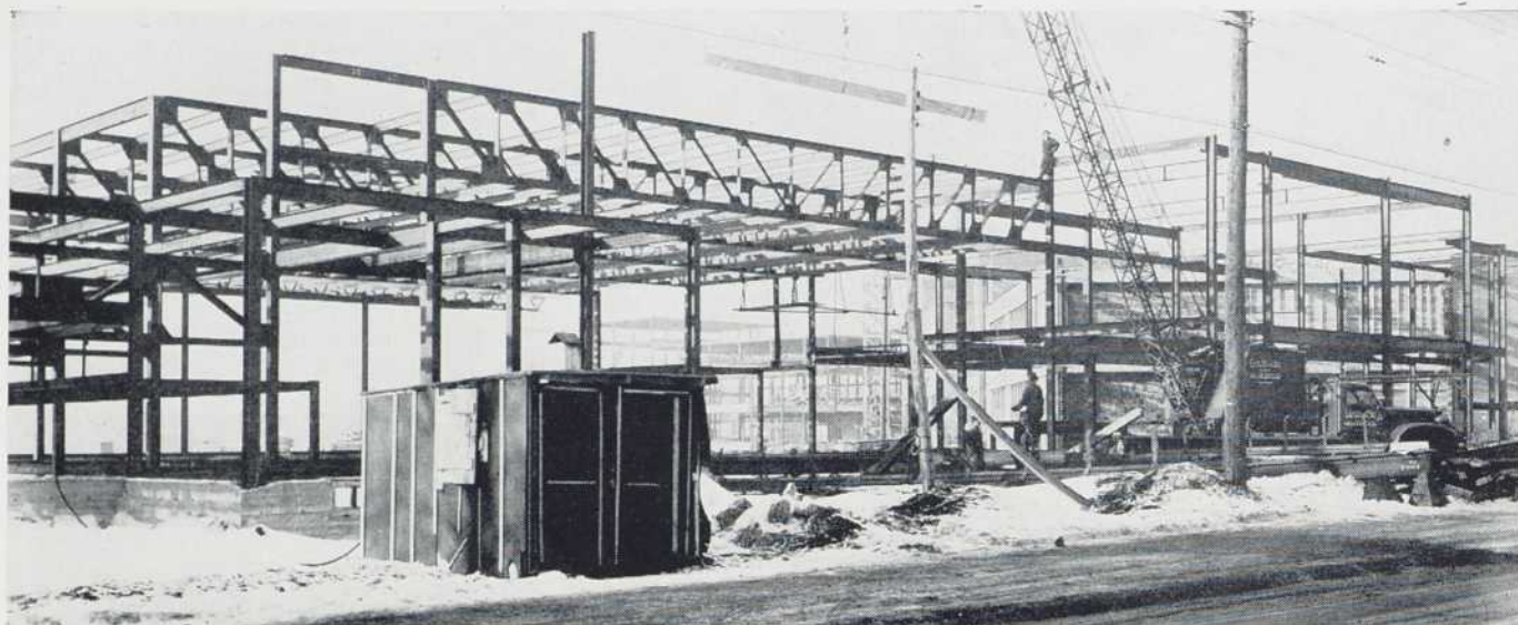
Monkland High School — Vue montrant les fermes de 80' supportant le toit du gymnase.
