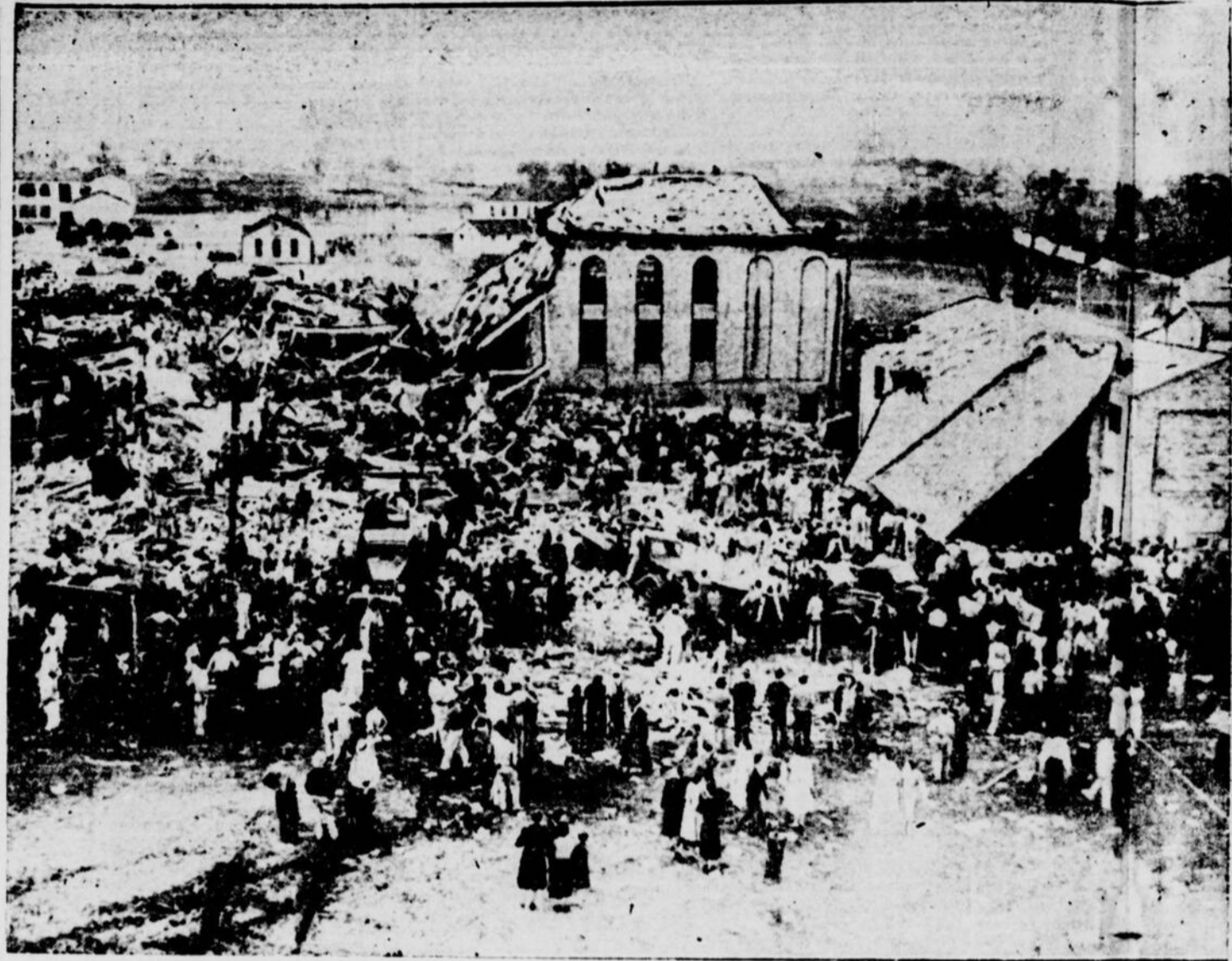
Une vue des ruines de l'école qui a sauté à New-London, Texas, et des terrains environnants, où 455 élèves, maîtres et maîtresses ont perdu la vie. Cette photo est la première de la scène du plus terrible des désastres aux Etats-Unis et montre une foule angoissée s'approchant pour aider aux sauveteurs et s'enquérir des chers disparus.
