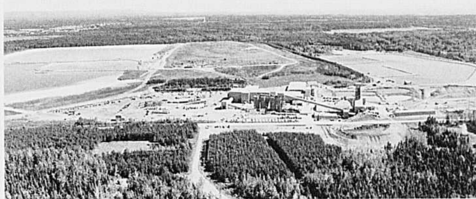
L'étude d'impact a identifié que 1 000 ha de potentiel de terres agricoles seront touchés par l'agrandissement de la mine Niobec, mais que seulement 28 ha sont actuellement en culture.
