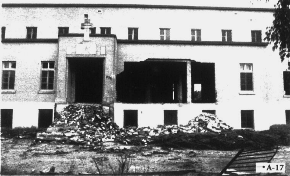
Alors que la démolition du vieux couvent est commencée, la Ville entreprend un processus de zonage pour autoriser la construction de deux immeubles de condos de quatre étages sur le site du 430 Champlain.
