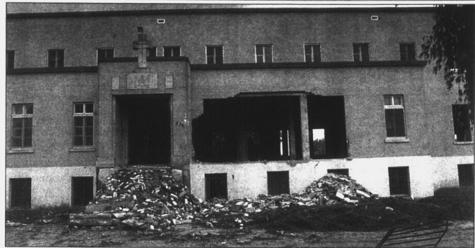
La démolition se fait de façon méthodique pour récupérer les différents matériaux.
