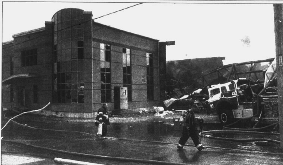
Seule la section des bureaux administratifs de Ready Pac est restée debout après l'incendie.
