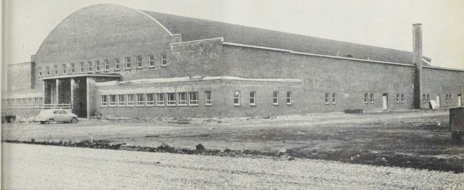
Aréna de Sorel, Qué. — Ingénieurs-Conseils : Pour la structure : Brouillet & Carmel, Montréal, Qué. — Pour les études de sol : Foundation Engineering of Canada, Montréal, Qué. — Entrepreneur : Lucien Lachapelle, Sorel, Qué.
