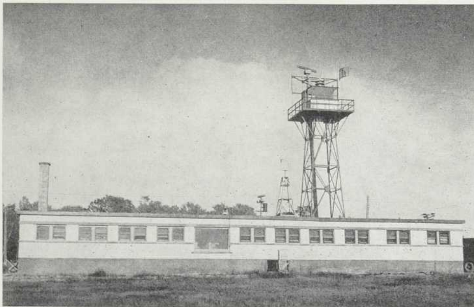
Fig. 3 — Le centre de contrôle avec sa tour qui domine le terrain.
