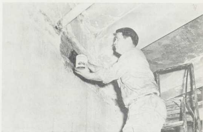
Fig. 3 — Le même produit est utilisé ici pour étanchéiser un mur du sous-sol où l'eau s'infiltrait et causait des dégâts périodiques au New York Athletic Club .
