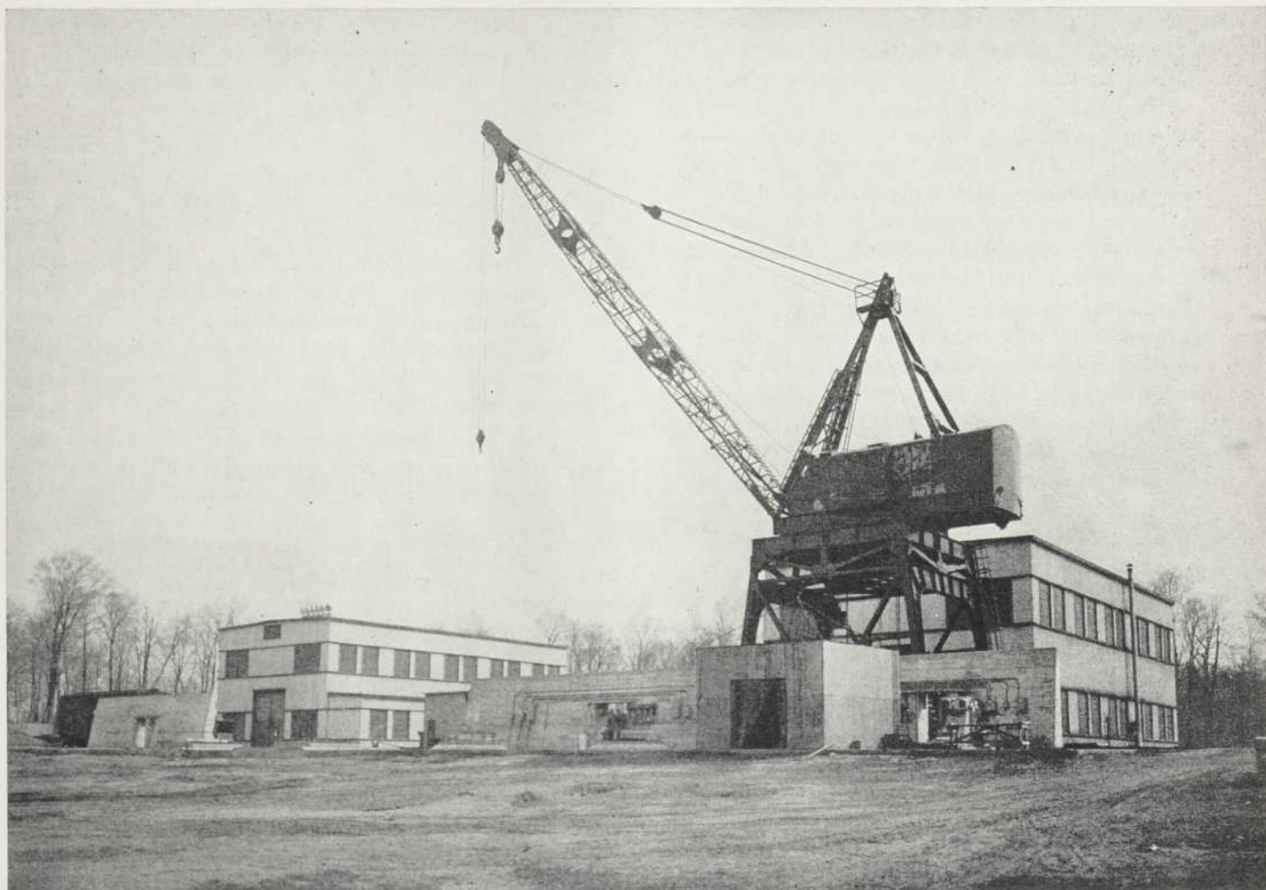
Fig. 9 — Plate-forme de tir de la batterie No 3. L'immense grue à pont roulant sert à installer les canons.
