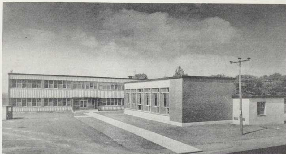
Fig. 1 — L'édifice principal abritant l'administration et les services généraux.
