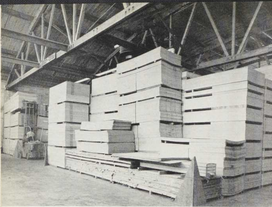
Un coin de l'entrepôt. La structure, longues fermes de bois, s'appuie sur les murs séparant les diverses sections et permet de longues portées libres de toute colonne intermédiaire. Chaque section couvre 15,000 pi. car. de surface.
