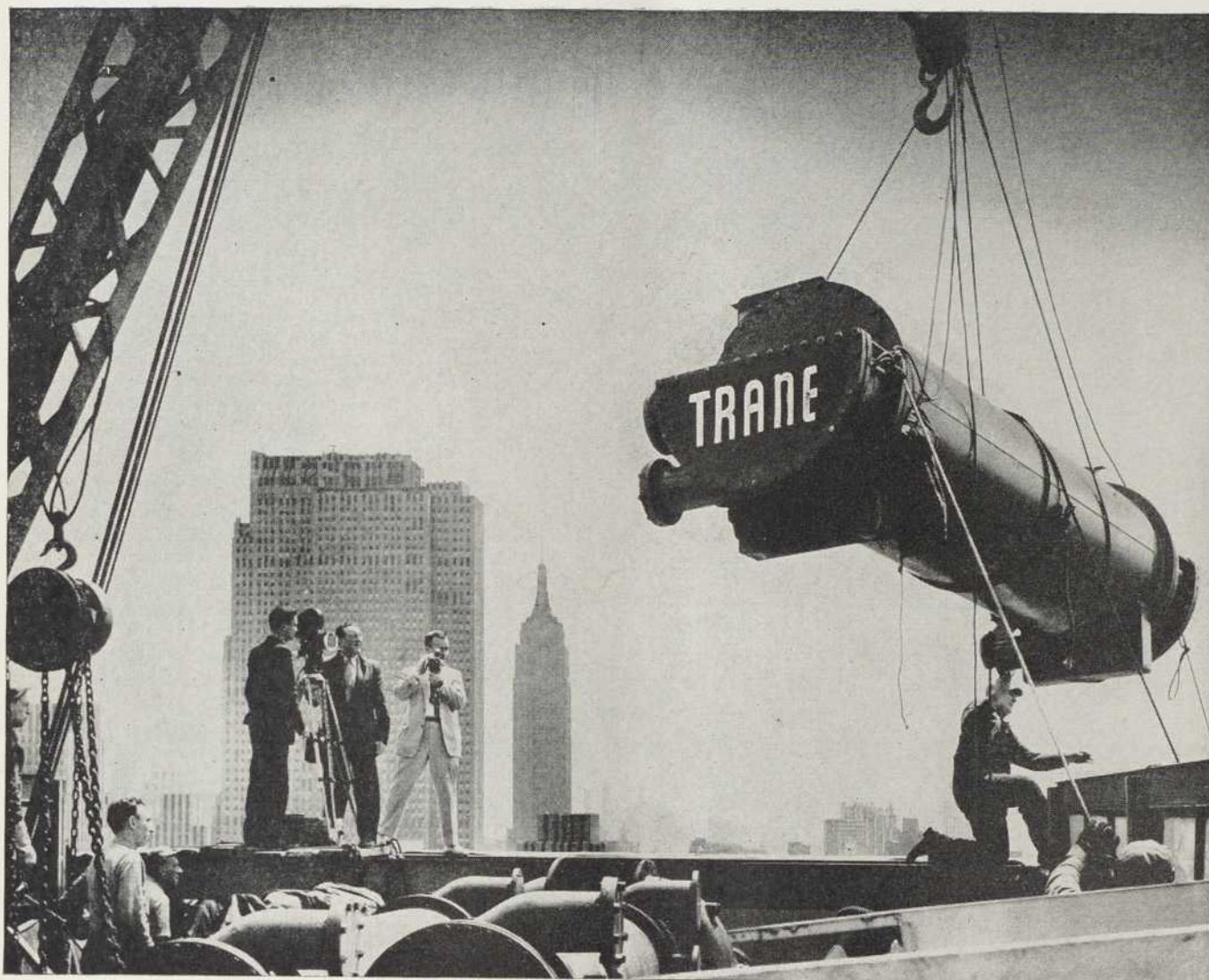
Au 40e étage , sur le toit de l'hôtel Barbizon Plaza, à New York, on procède à l'installation d'un CenTraVac Trane. Deux appareils du genre assureront un refroidissement égal à la fonte de plus d'un million de livres de glace par jour.
