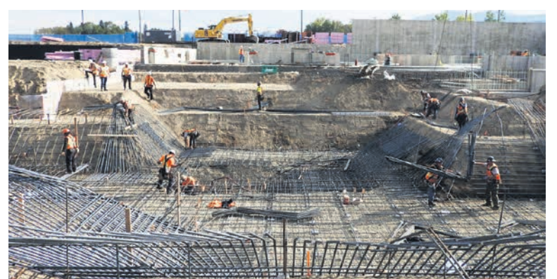
Environ 50 travailleurs s'activent sur le chantier. Ce nombre passera à plus de 200 lorsque les travaux d'architecture et électromécanique seront exécutés.
