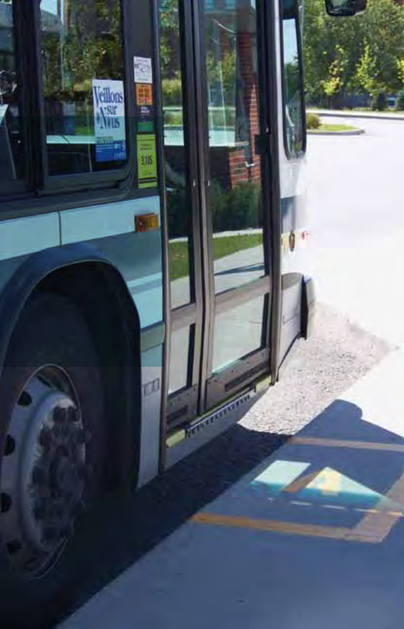
Figure 10 – Hauteur du trottoir insuffisante.
