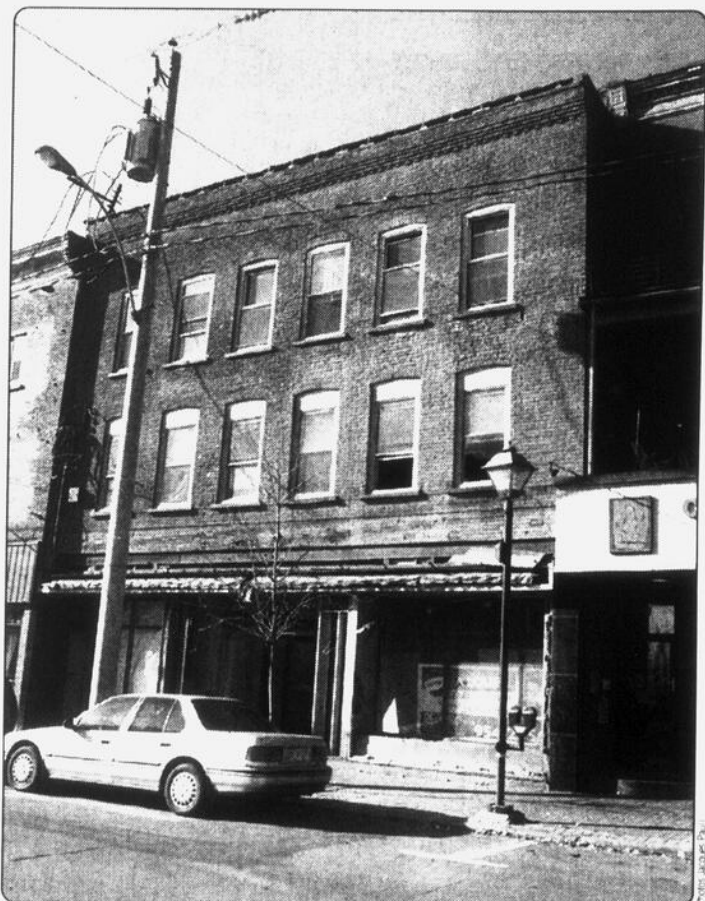
137 immeubles du Vieux-Saint-Jean ont bénéficié d'une aide à la rénovation.
