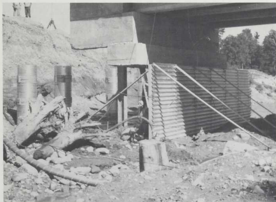
Les pieux d'ancrage et la paroi d'acier étagée temporairement avant le remblayage. Le lit de la rivière a été rétabli à son niveau primitif, c'est-à-dire à la hauteur du sommet de la paroi d'acier
