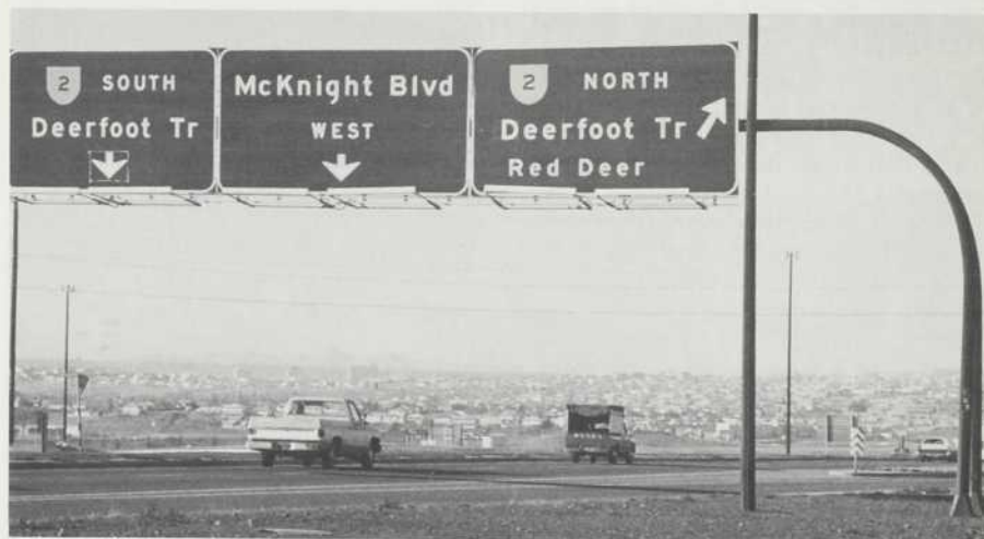
Les supports de panneaux de signalisation et les lampadaires de Calgary sont faits d'acier patinable exigeant peu ou pas d'entretien
