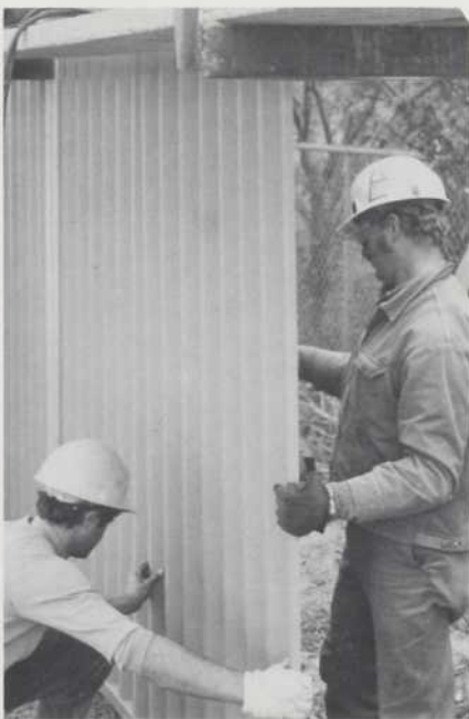
Fixation d'un panneau en tôle d'acier prépeinte à l'écran construit le long de la route 401, à Toronto
