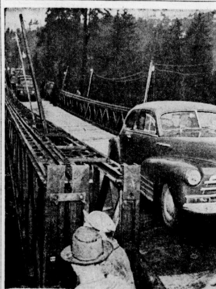
LE GENIE MILITAIRE de l'armée canadienne a terminé hier la construction de ce pont "Bailey" qui remplacera temporairement le pont de la Capilano, dans la partie ouest de Vancouver. Le pont
