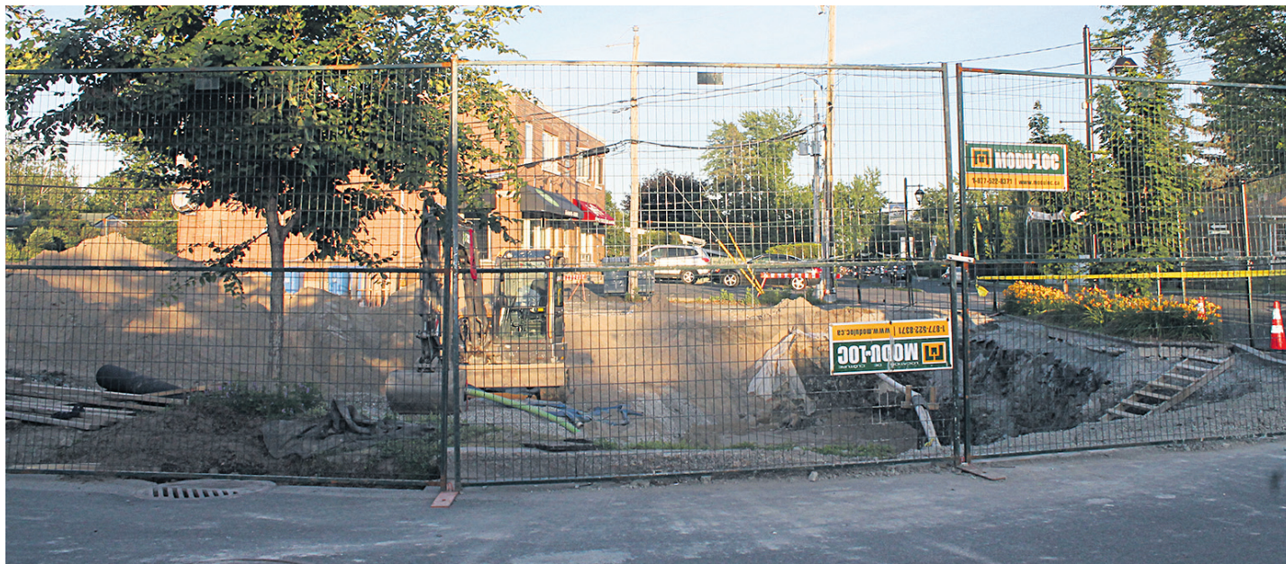
Des travaux sont en cours à l'intersection de la montée Robert et de la rue Savaria pour aménager une halte du Village. (Photo : Frank Jr Rodi)
