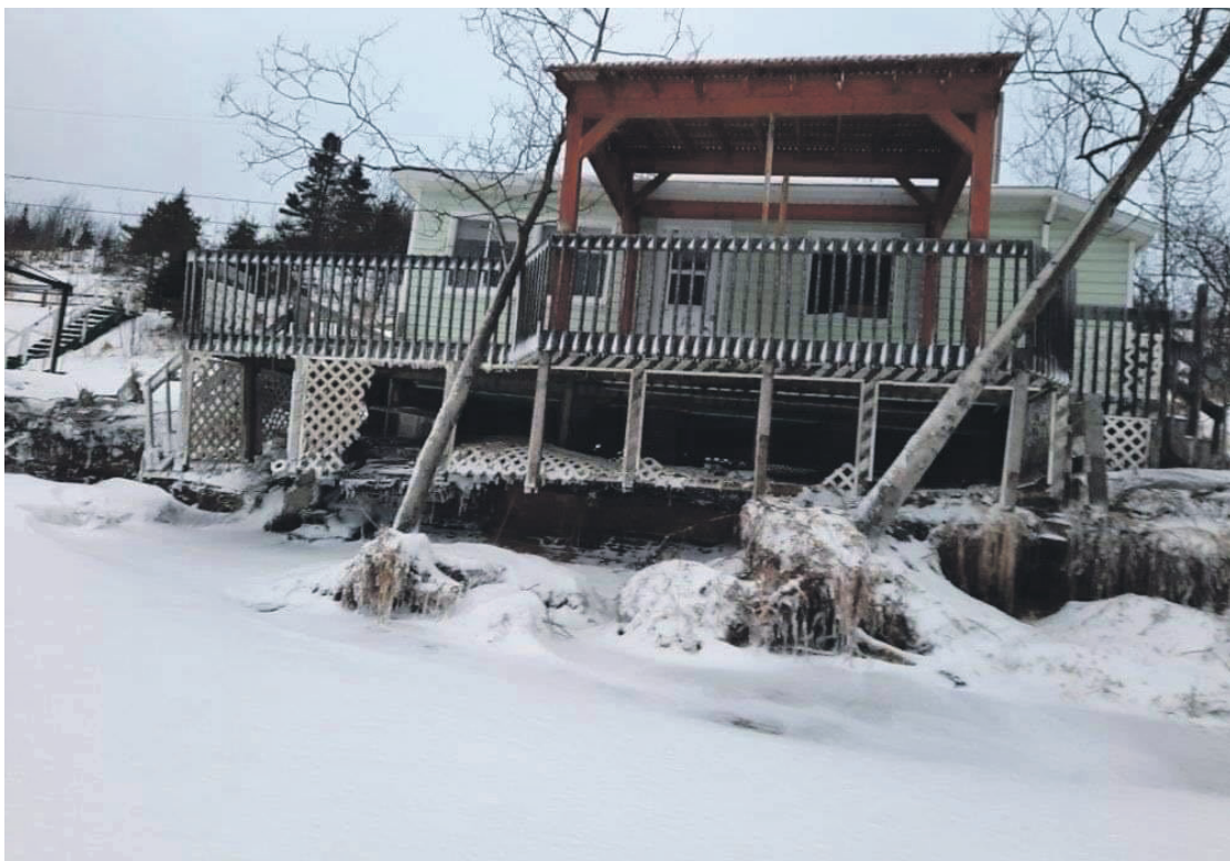
La tempête des 23 et 24 décembre s'est avérée destructrice pour les résidents du Cap Colombier. Les dommages causés par les vents forts ne sont toutefois pas couverts par le programme du ministère de la Sécurité publique. Photo courtoisie
