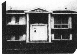
Splendide bungalow super-isolé-7 1/2 pièces-sous-sol bien aménagé-remise-beau terrain paysagé & entrée asphaltée-situé secteur résidentiel rue J. Viel, Rivière-du-Loup.
