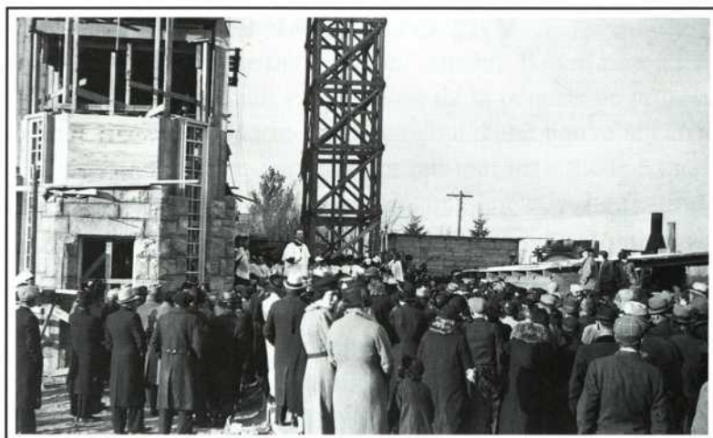
Construction de l'église actuelle (1939)
