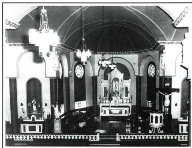
Intérieur de la première église (chœur)
