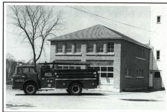
Première caserne des pompiers
