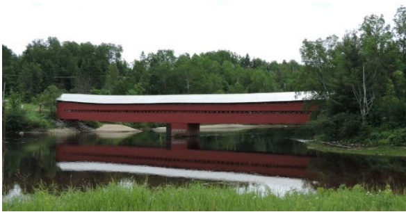
Grand pont de Ferme-Rouge, vue latérale
