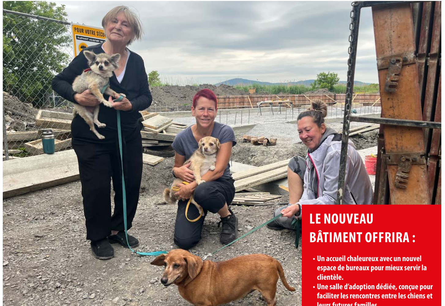
Le nouveau bâtiment de la SPCA Montérégie devrait être prêt au mois d'octobre. (Photos : Jean-Christophe Noël)
