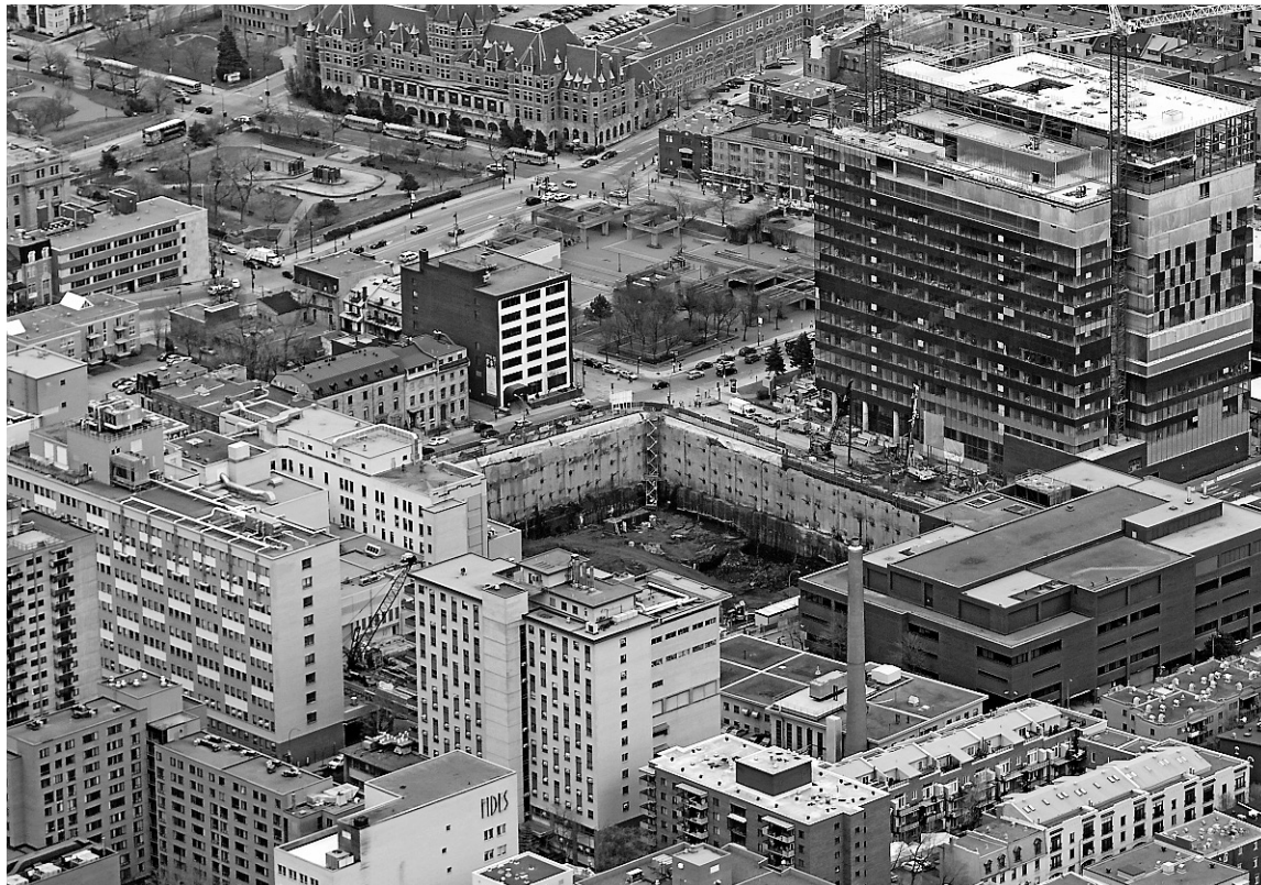
Le chantier de construction du nouveau Centre hospitalier de l'Université de Montréal (CHUM), juste derrière l'actuel hôpital Saint-Luc.
