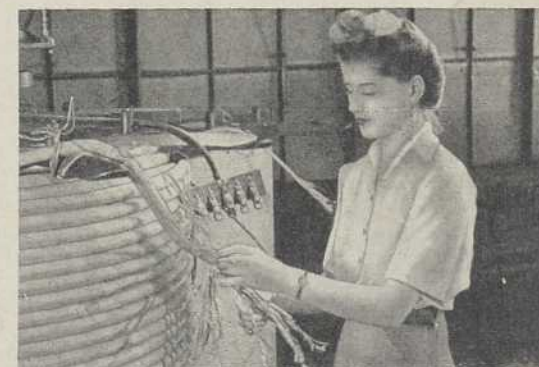
Epreuve de résistance de capacité d'un câble de téléphone.
