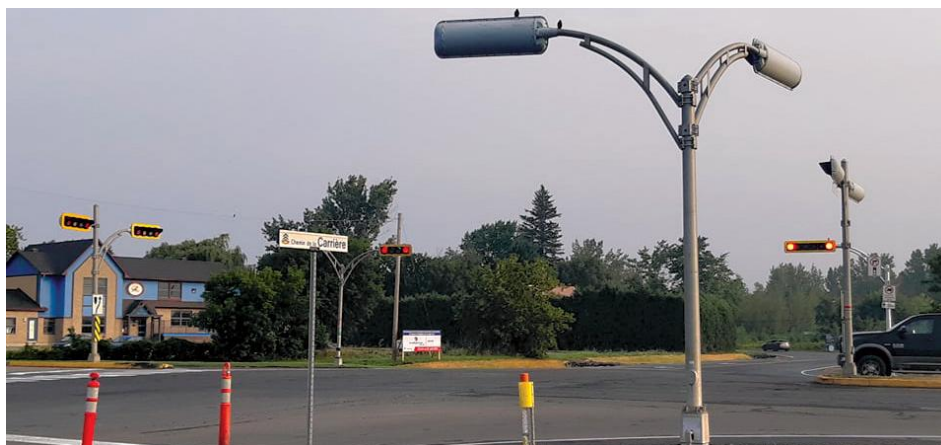
Des boutons n'activent pas le droit de passage des piétons après des travaux. (Photo : archives)
