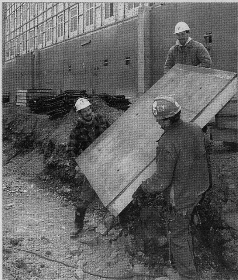
L'Association de la construction du Québec dénonce la publicité de la CSST sur les accidents sur les chantiers de construction.
