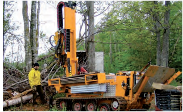
Foreuse Geotech sur le terrain
