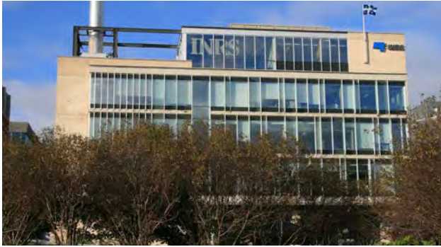
Édifice INRS au centre-ville de Québec
