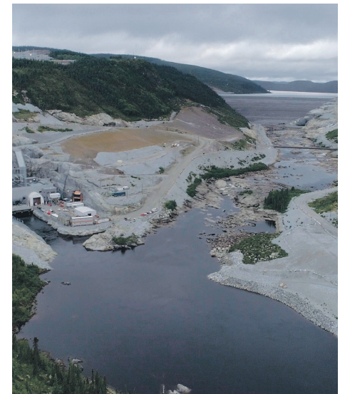
Romaine 4 est à l'arrêt depuis la fin du mois de novembre. Le poids de la glace, qui s'est accumulée sur les lignes électriques reliant le barrage, était bien au-delà de la capacité mécanique des conducteurs et des pylônes. Photo Hydro-Québec
