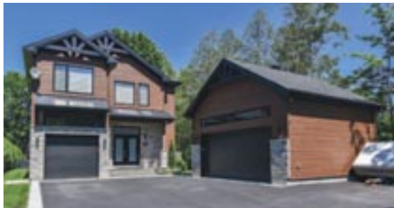
BORD LAC CONNELLY (navig.) – Impeccable propriété 2019, garage simple + garage double. 3 CAC, 2 SDB, 1 S-E. Foyer au propane. Sous-sol fini. Terrain entièrement paysager. Centris 21064742. 1349000$ Carmen
