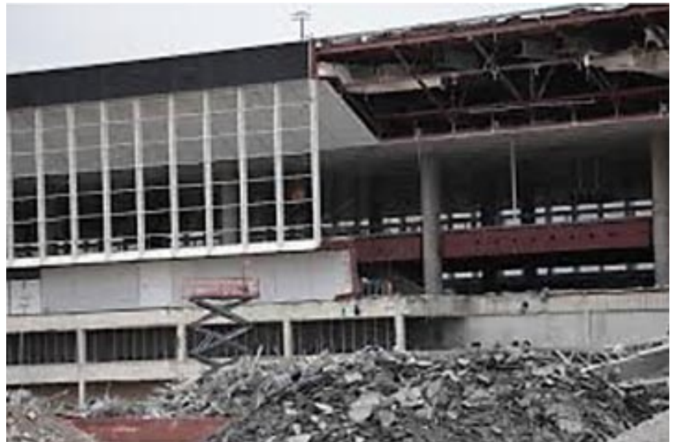
Démolition de l'aérogare.
