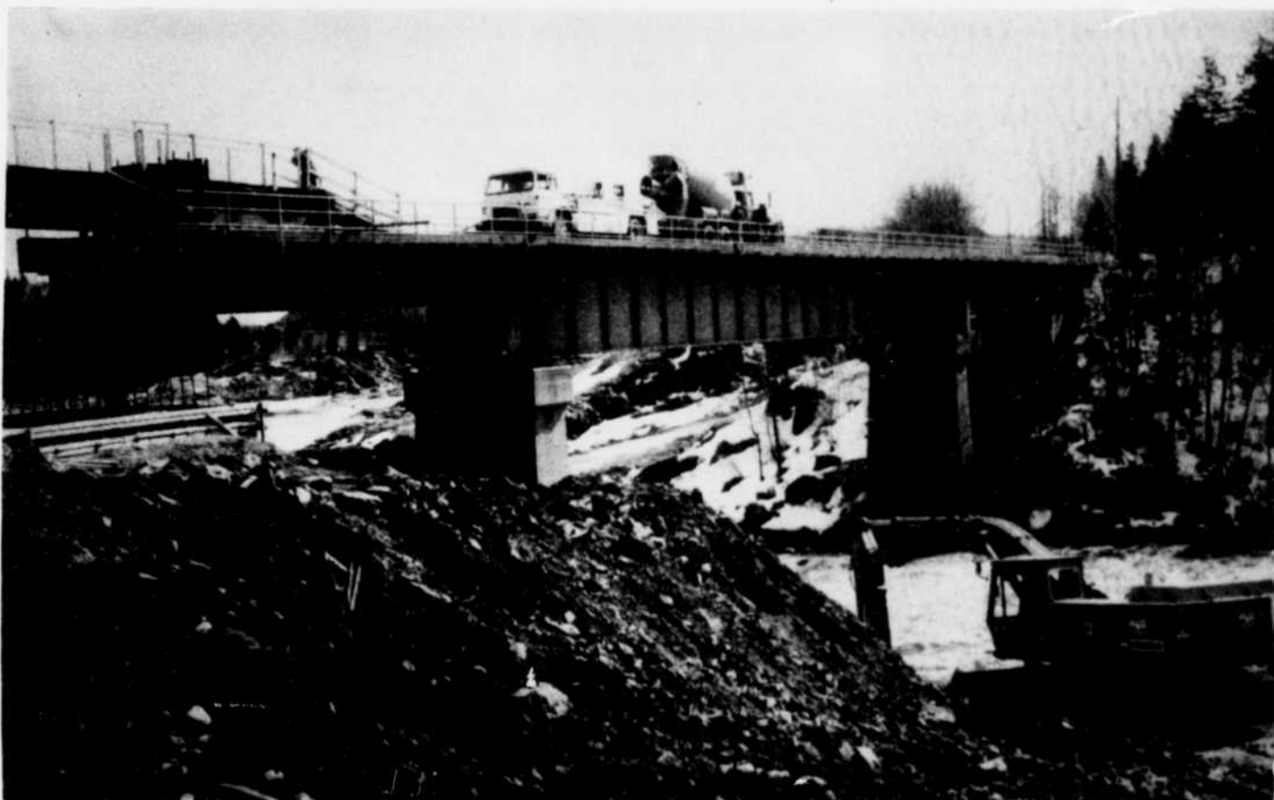
On s'affaire actuellement à consolider le remblai qui avait été endommagé par l'érosion.
