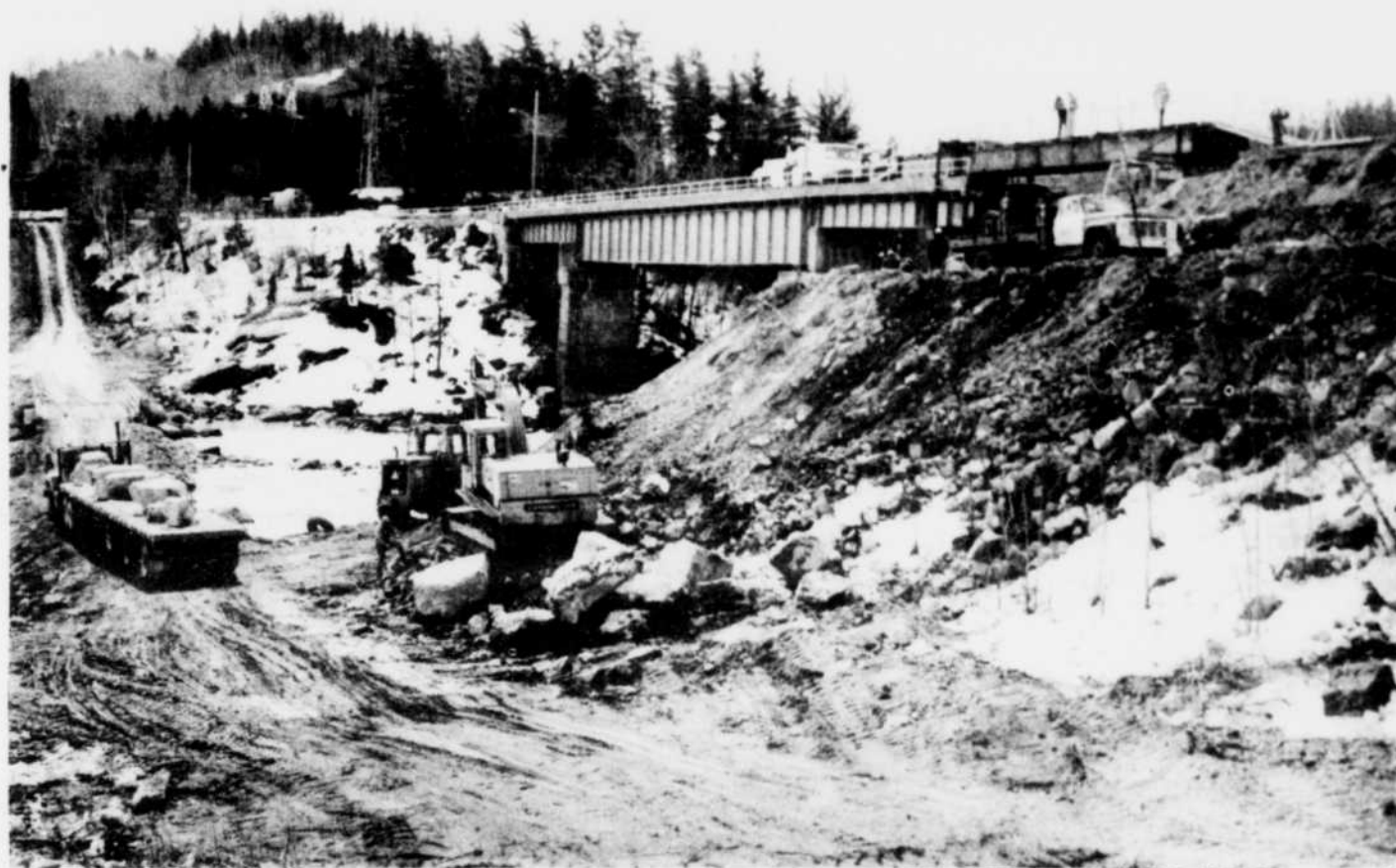
À gauche, on voit le pont temporaire qui a été érigé sur la rivière.
