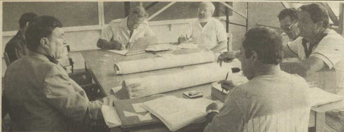
Des réunions de chantier ont lieu régulièrement à l'école de St-Alphonse. Hier, l'architecte Paul-O Trépanier (au fonds à gauche) dirigeait la rencontre à laquelle assistaient entre autres M. Rock Beauregard de la CS de Granby (à ses côtés) et M. Martial Gousy, directeur de l'école (de dos).
