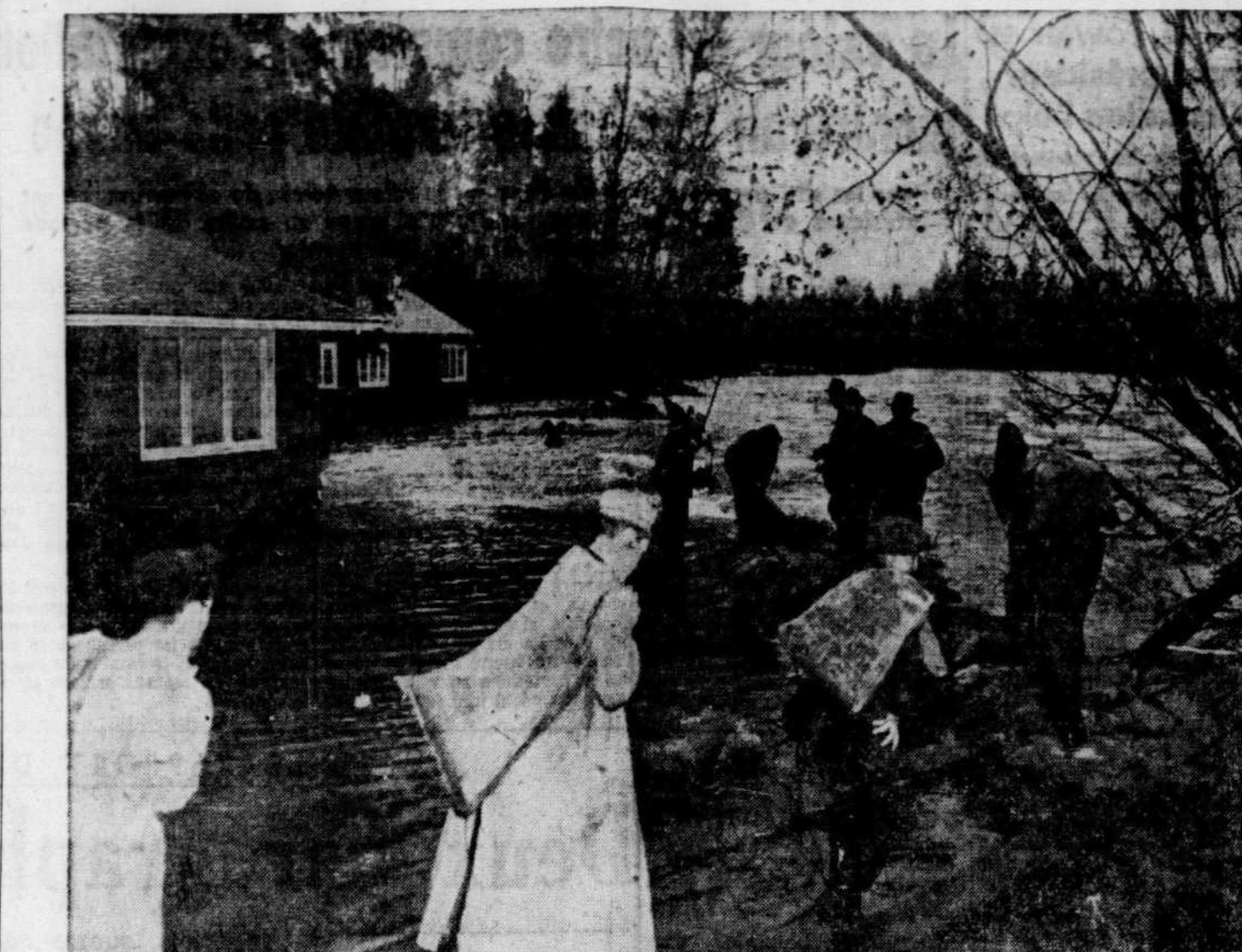
L'EQUIPE DE SECOURS — Des volontaires et des soldats transportent des sacs de sable pour élever une digue contre les flots menaçants de la rivière Seymour à Vancouver-nord. A la suite de grosses pluies la rivière est sortie de son lit et menace les propriétés de Vancouver-nord et Vancouver-sud.
