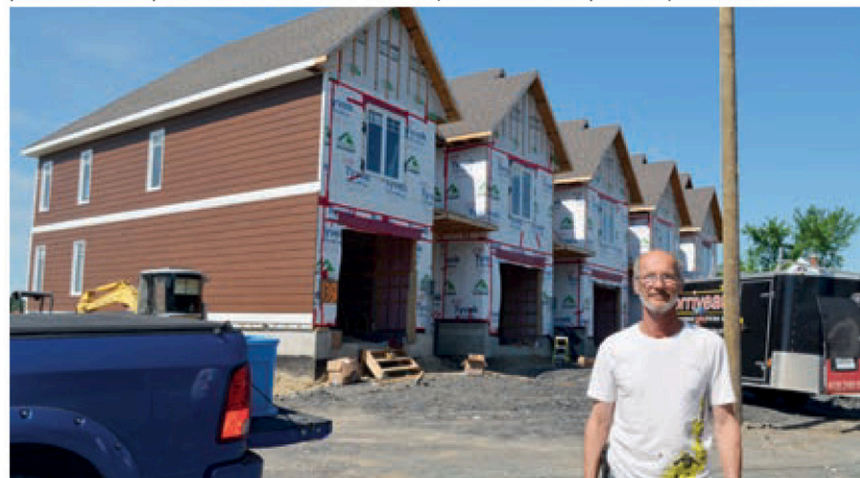
Doris Beaudoin devant les maisons de ville en construction sur la route 277, qui devraient être prêtes d'ici la fin du mois de juillet. (Photo La Voix du Sud)
