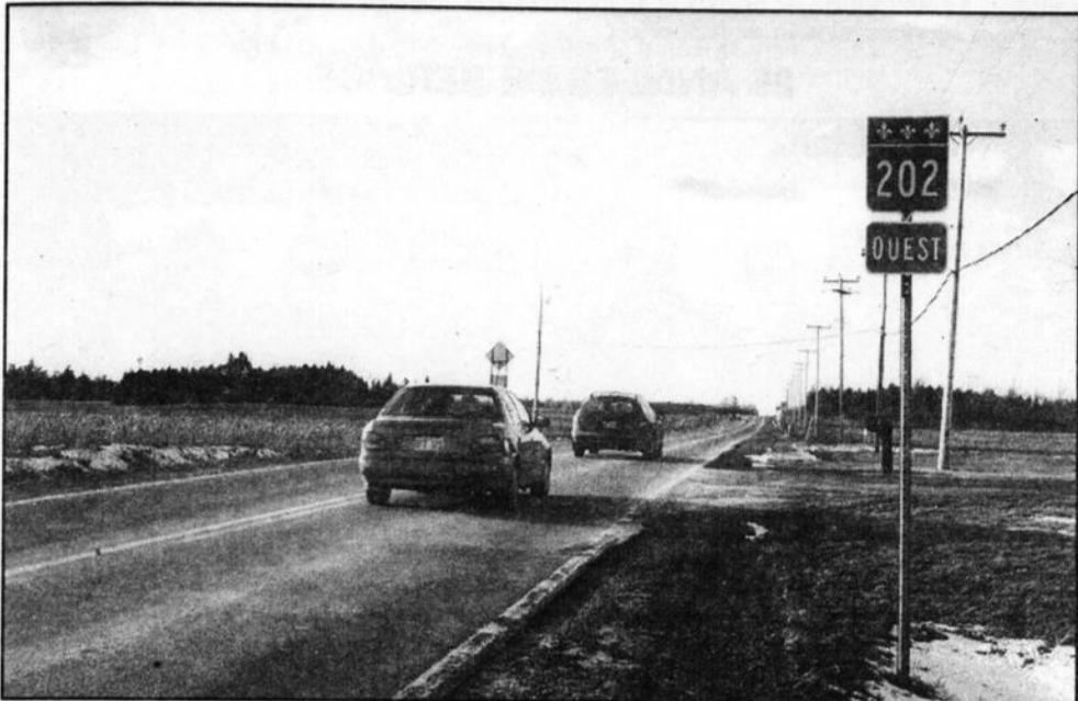
Même si plusieurs segments de cette route ont été refaits à neuf ces derniers mois, la 202 présente encore des signes évidents de dégradation. Le tronçon compris entre Sainte-Barbe et Huntingdon s'est considérablement endommagé au fil des dernières années, rendant la vie difficile aux automobilistes et aux camionneurs qui l'empruntent quotidiennement. (photo P.L.)
