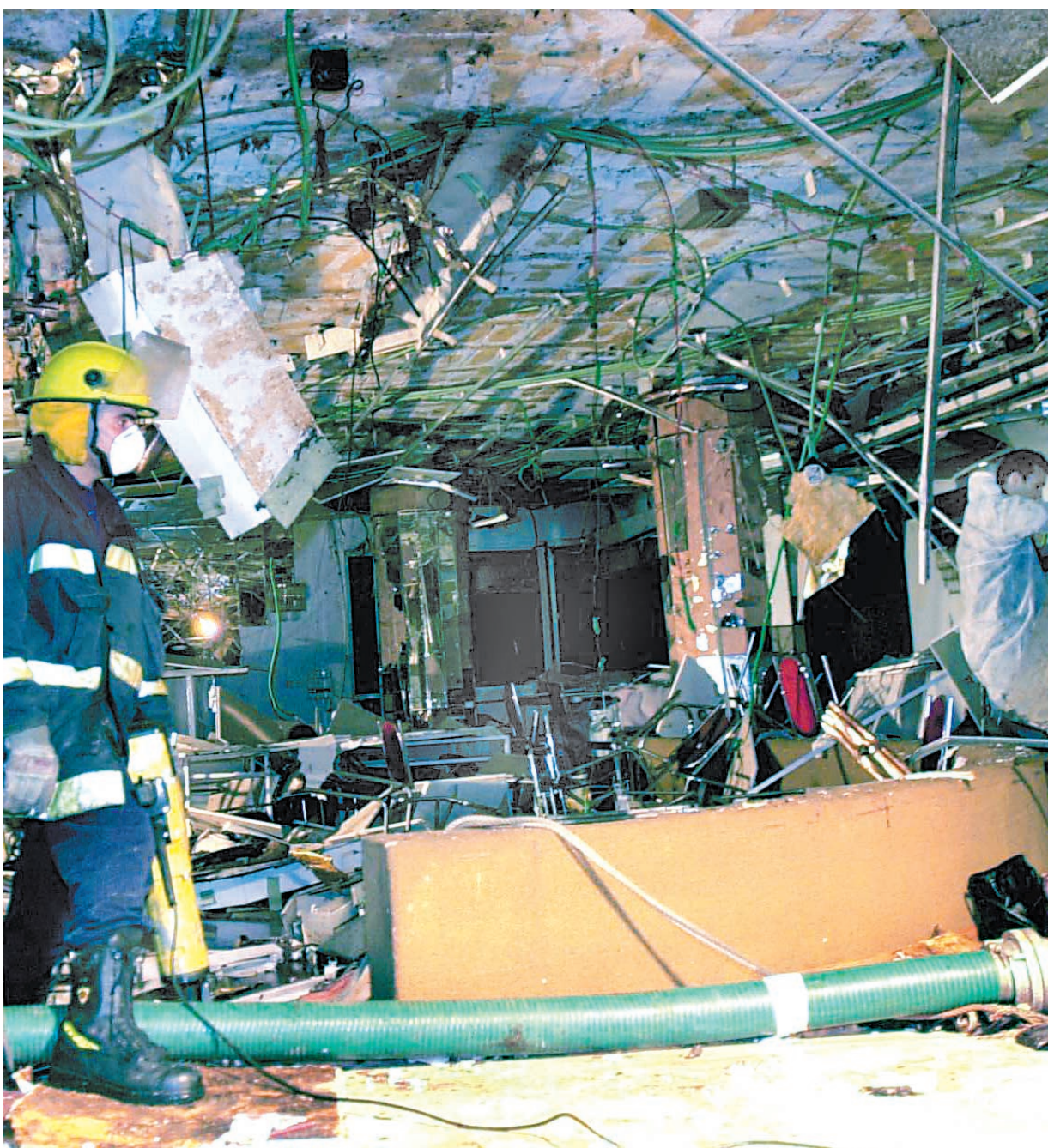
Des secouristes observent les dégâts causés hier par l'attentat suicide qui a dévasté un hôtel de Netanya, station balnéaire près de Tel-Aviv, en Israël. Autres informations en page A18.
