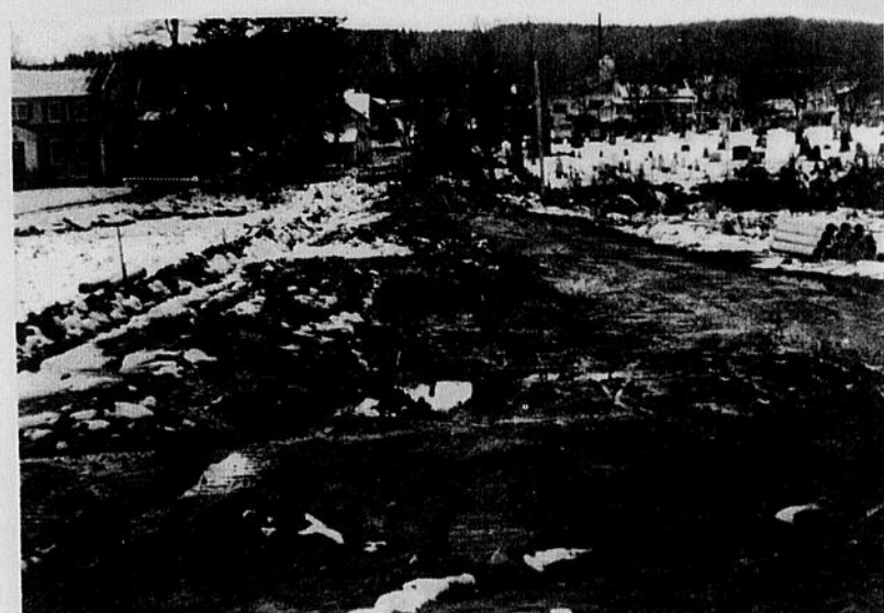
Depuis quelques semaines on travaille à Beauceville-Ouest à l'élargissement de l'avenue Lambert et de la rue du cimetière en raison de la très forte affluence de camions dans ce secteur où il y a deux importantes industries et une autre en construction. Cette photo fait voir la largeur de la rue du cimetière où il y a quelque temps deux autos avaient de la peine à se rencontrer. L'avenue Lambert sera élargie de la même façon incessamment.
